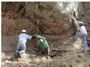
Nattes de jute utilisées pour prévenir l'érosion due aux inondations, tandis que la végétation naturelle s'établit UNIQ-ref-0-f8314270b8263ef1-QINU
