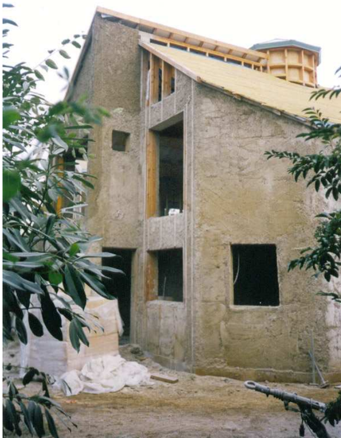
Figure 5. Utilisation du chanvre dans le bâtiment 16 © A. Evrard / CenC
