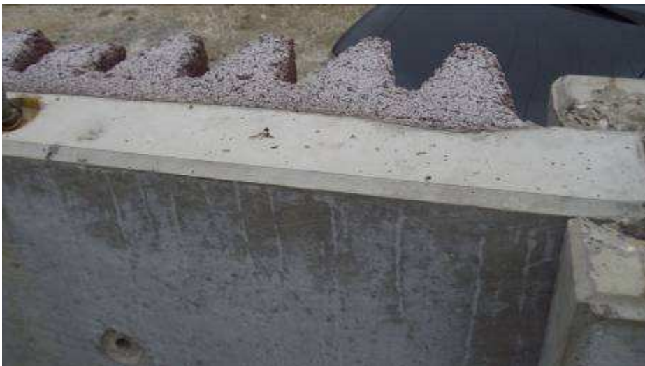
Figure 11 Mur anti-bruit, vue du dessus 8
