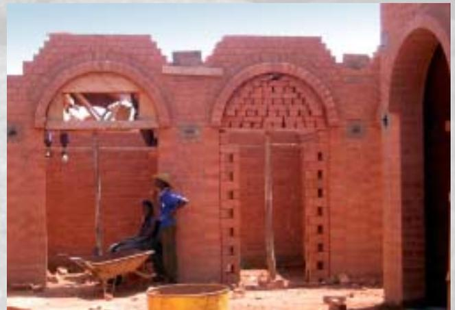
solution économique et très pratique est d'utiliser les cadres, qui serviront plus tard de fenêtres pour fabriquer les coffrages. Des coffrages temporaires peuvent aussi être réalisés avec des briques.
