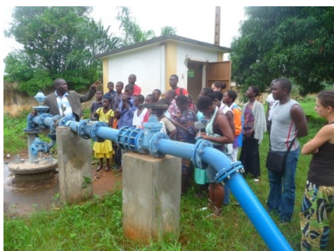
Station de traitement des eaux de Cacavelli
