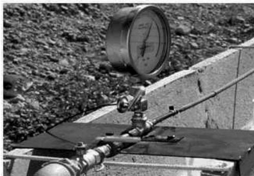
**Les purgeurs d'air.** Ces purgeurs sont de grande importance car ils protègent le réseau de conduites contre les dommages provoqués par des poches d'air emprisonnées dans le système ou leur mise sous vide. S'ils sont mal sélectionnés ou placés, ils peuvent causer d'importants problèmes de fonctionnement.
