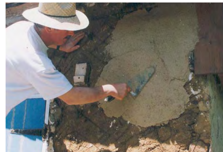
Pose de l'enduit
