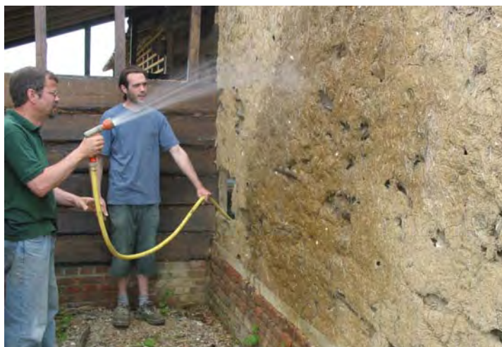
Préparation de l'accroche de l'enduit
