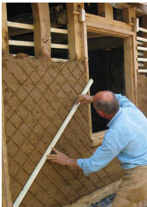
préparation à la pose de l'enduit
