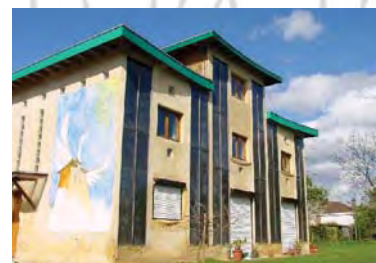
Deux constructions contemporaines
