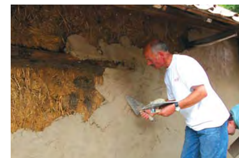
application de l'enduit
