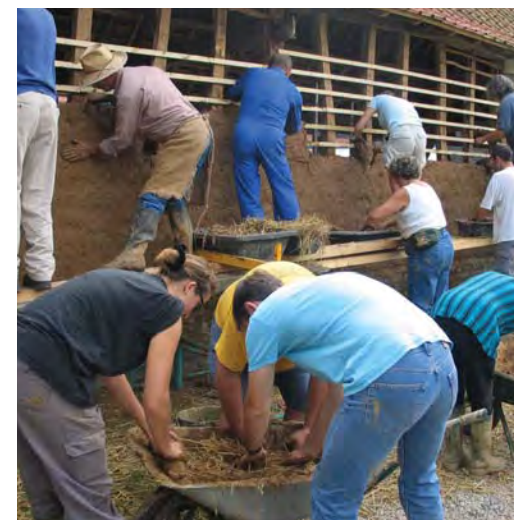
exemple d'un chantier de restauration
