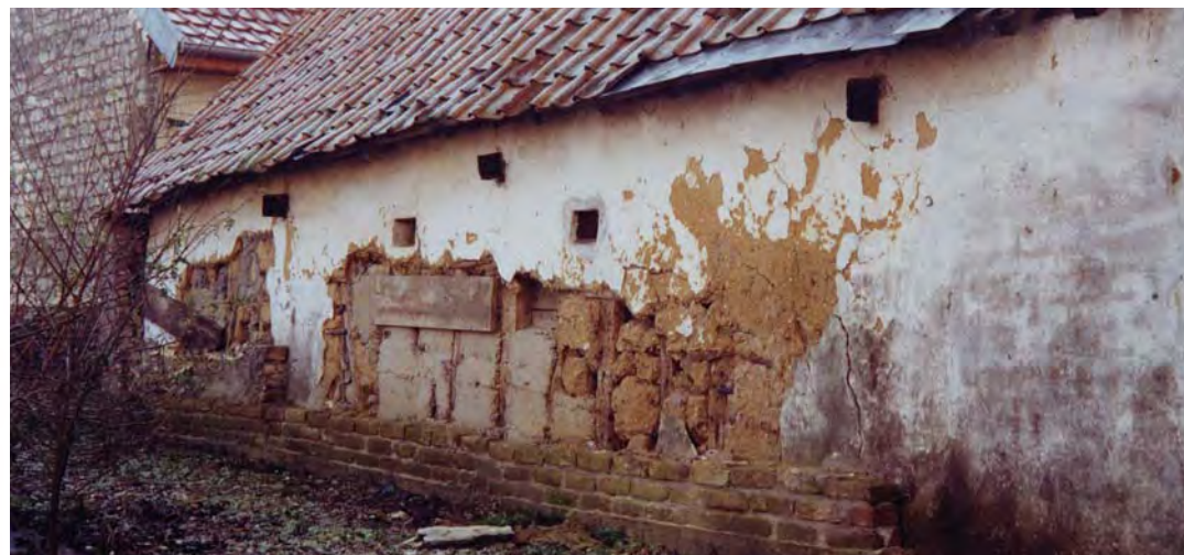
Mauvaise gestion des eaux de pluie
