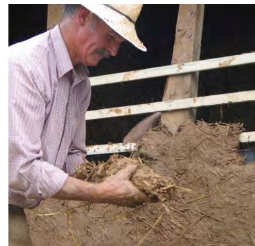
réalisation d'une torche
