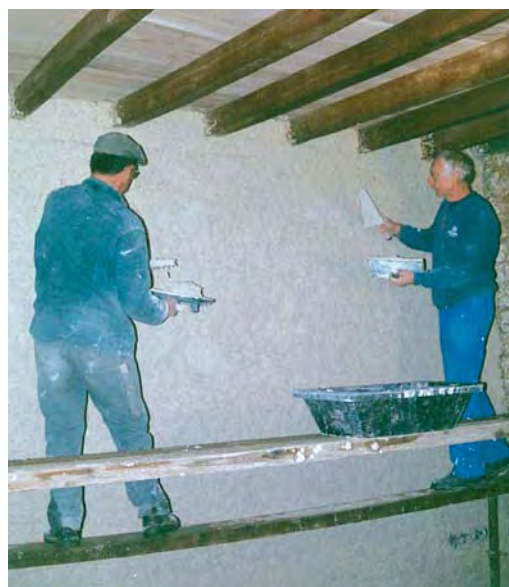
Pose d'un enduit allégé
