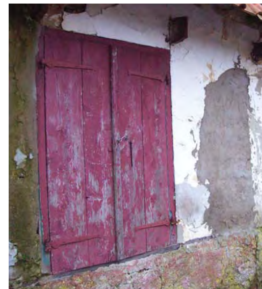
Présence de ciment
