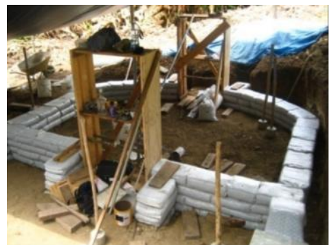
BELOW: WOOD DOOR FRAMES
