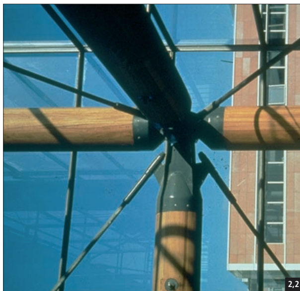
Fig. 2,2 Un classement de structure permettra de développer l'usage des bois ronds en structure.
