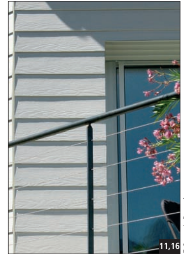
Fig. 11,15 Pose de lames décalées.
