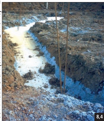
Fig. 8,4 Sur les sols hétérogènes, la semelle est armée.
