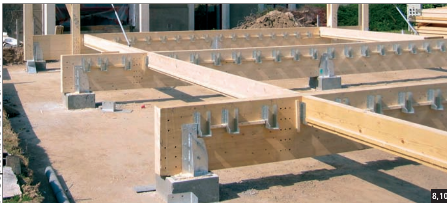
Fig. 8,10 Les longrines en bois sont fixées par une ferrure métallique.
