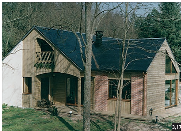
Fig. 3,17 L'association de revêtement mural en briques maçonnées, en crépis et en lames de bardage verticales et horizontales apportent de grandes possibilités architecturales.
