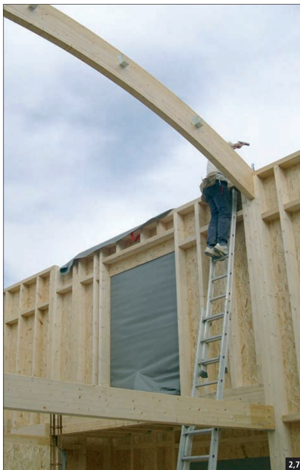
Fig. 2,7 Une poutre à inertie constante à la même section sur toute sa longueur.
