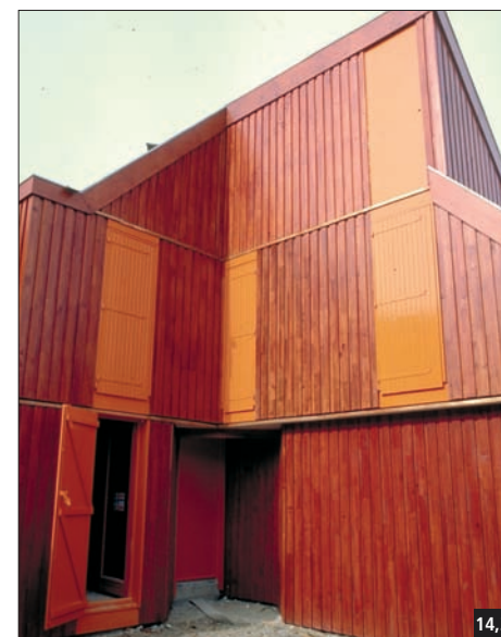
Fig. 14,3 Une finition soignée nécessite un support poncé avec un égrenage entre les couches.
