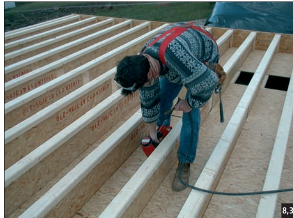
Fig. 8,35 Entretoises croisées d'un plancher (application similaire pour les dalles bois).
