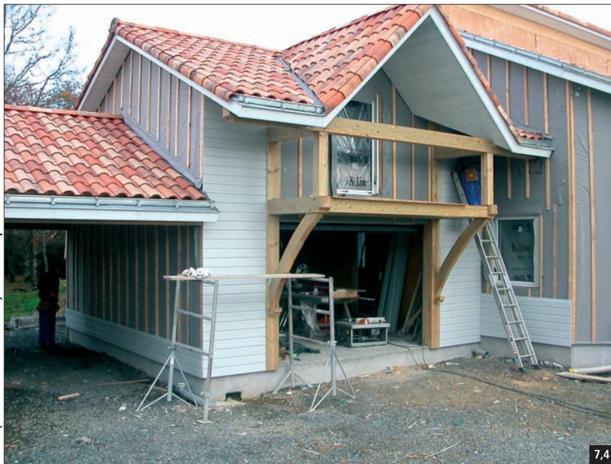
Fig. 7.4 Ce large débord de toiture protège les murs et les menuiseries de la pluie.
