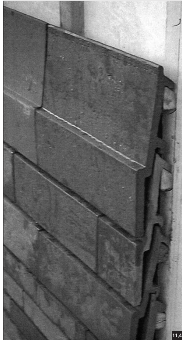
Fig. 11,41 Bardeaux de terre cuite à double accrochage.
