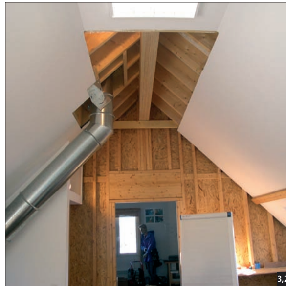
Fig. 3,20 Les plaques de plâtres sont largement utilisées dans les constructions à ossature bois.
