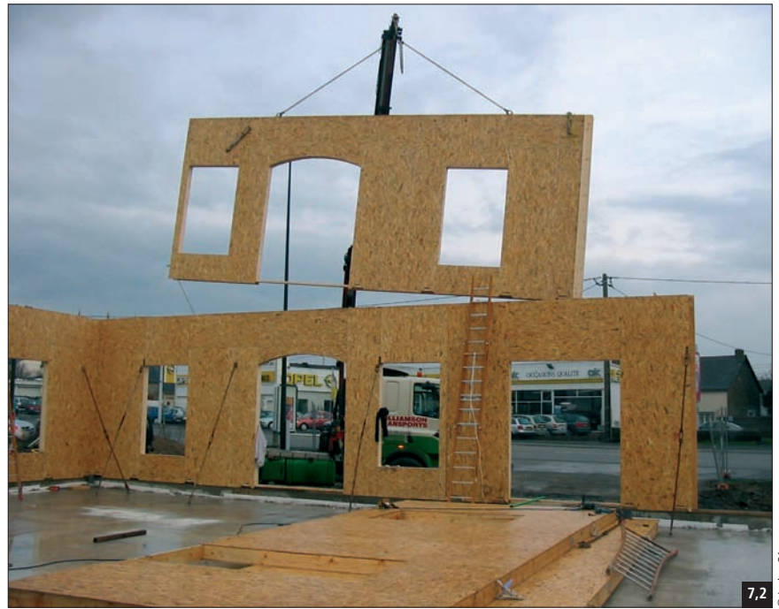
Fig. 7.2 La construction par grands panneaux est le procédé le plus utilisé en France.
