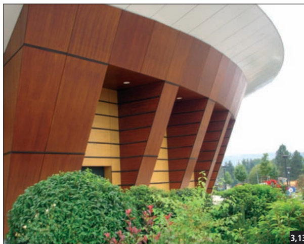
Fig. 3,13 et 3,14 Panneaux de parement extérieur bois en panneaux dérivés du bois.
