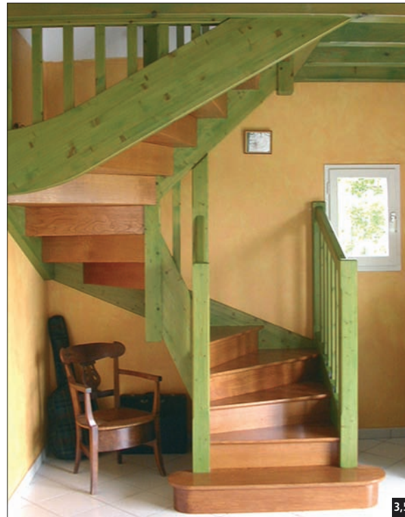
Fig. 3,5 Escalier avec quartier tournant haut et bas.
