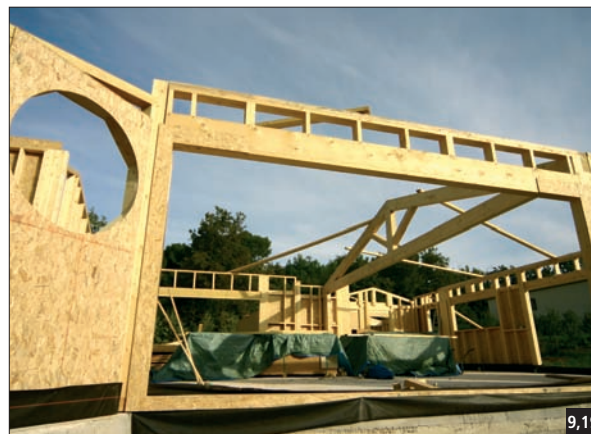
Fig. 9,18 Mise en œuvre des ouvertures dans la paroi.
