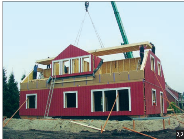
Fig. 2,24 et 2,25 Les caissons planchers industrialisés permettent de déplacer le travail à l'atelier.
