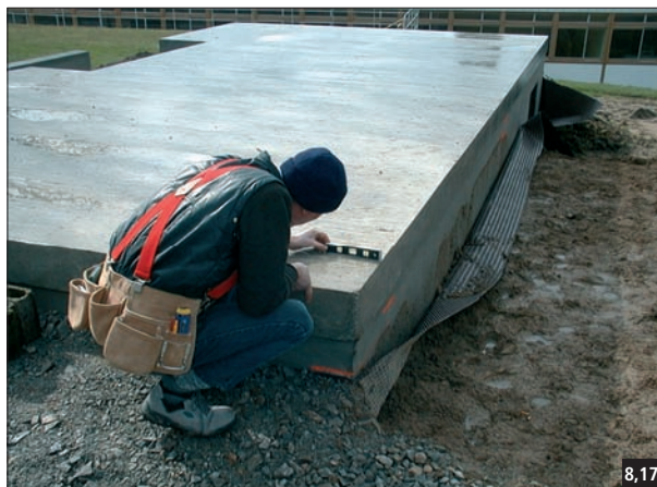
Fig. 8,18 Le surbot permet au maçon de respecter plus facilement les tolérances de la dalle ; il est coulé en même temps que celle-ci.
