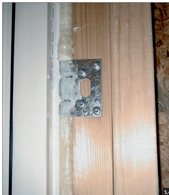
Fig. 5,3 Ce cordon de mastic renforce l'étanchéité entre la lisse basse et la traverse basse et entre les deux montants des panneaux.
