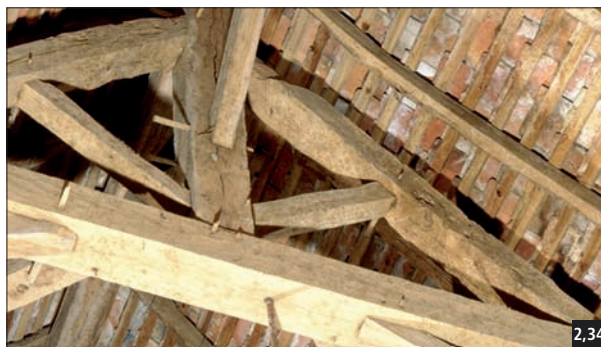
Fig. 2,36 Cette ferme sur blochet permet un aménagement des combles grâce à l'entrait retroussé.
