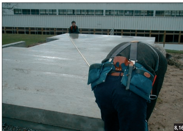
Fig. 8,16 Équerrage : décimètre (mesure des diagonales).
