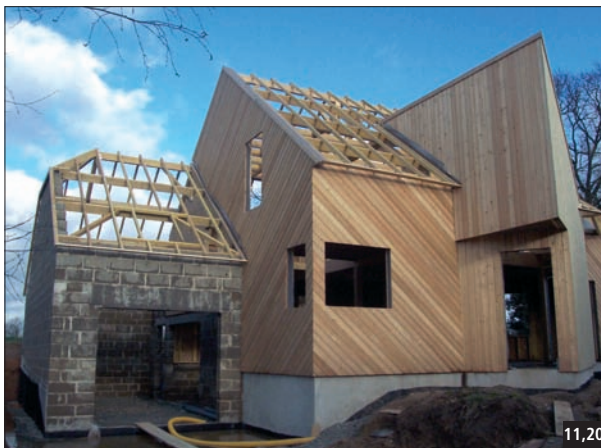
Fig. 11,21 La ventilation est optimum lorsque les tasseaux sont verticaux pour la pose horizontale des lames.
