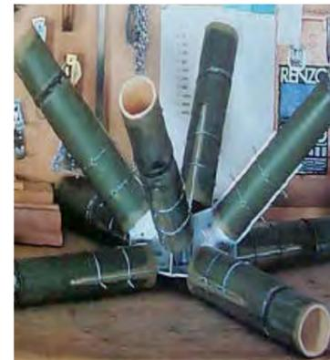
Les tubes de RENZO PIANO sont connectés à un élément en acier spécialement dessiné via un câble attaché.
