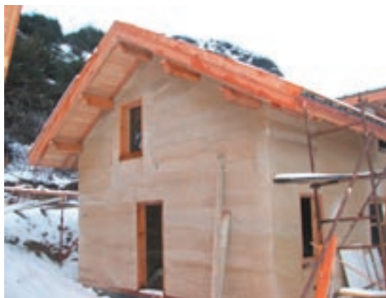
Futur gîte en chanvre banché et ossature bois (Saint-Martin-De-Queyrières - 05)
