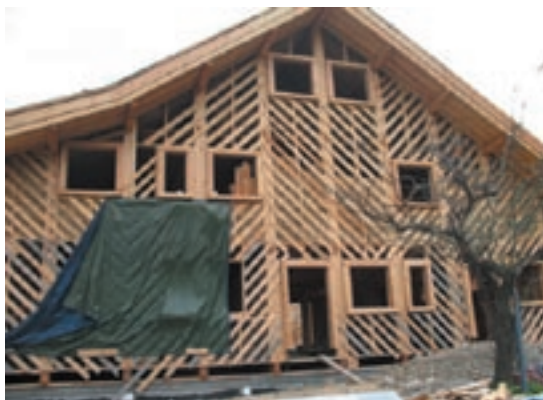
Maison à ossature bois et isolation paille (Champcella - 05)
