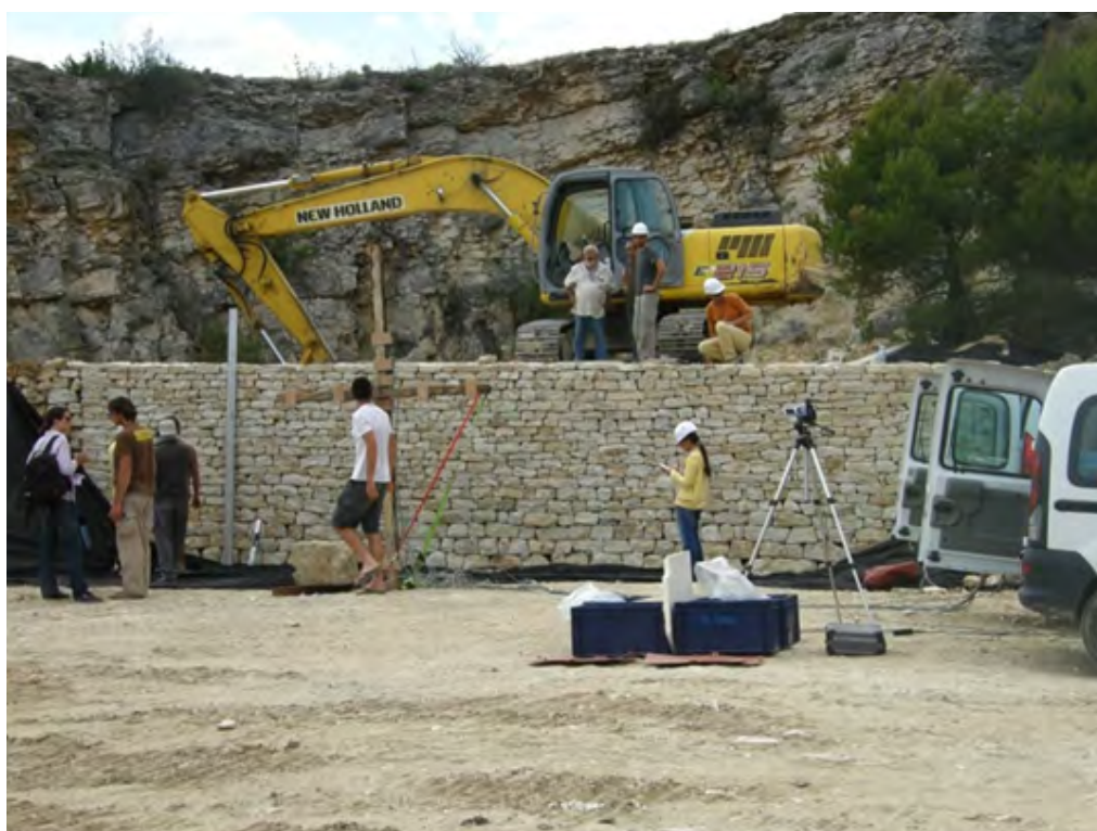
PEDRA: Soutènement expérimental à Saint Saturnin les Apt, Vaucluse, France, Murailleurs de Provence et ENTPE, 2011.
