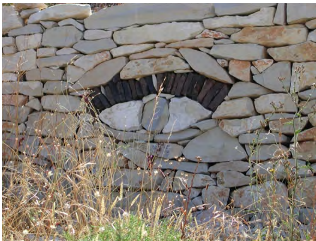
Soutènement du talus de la ligne TGV Méditerranée à Tavel, Gard, France, 1998.
