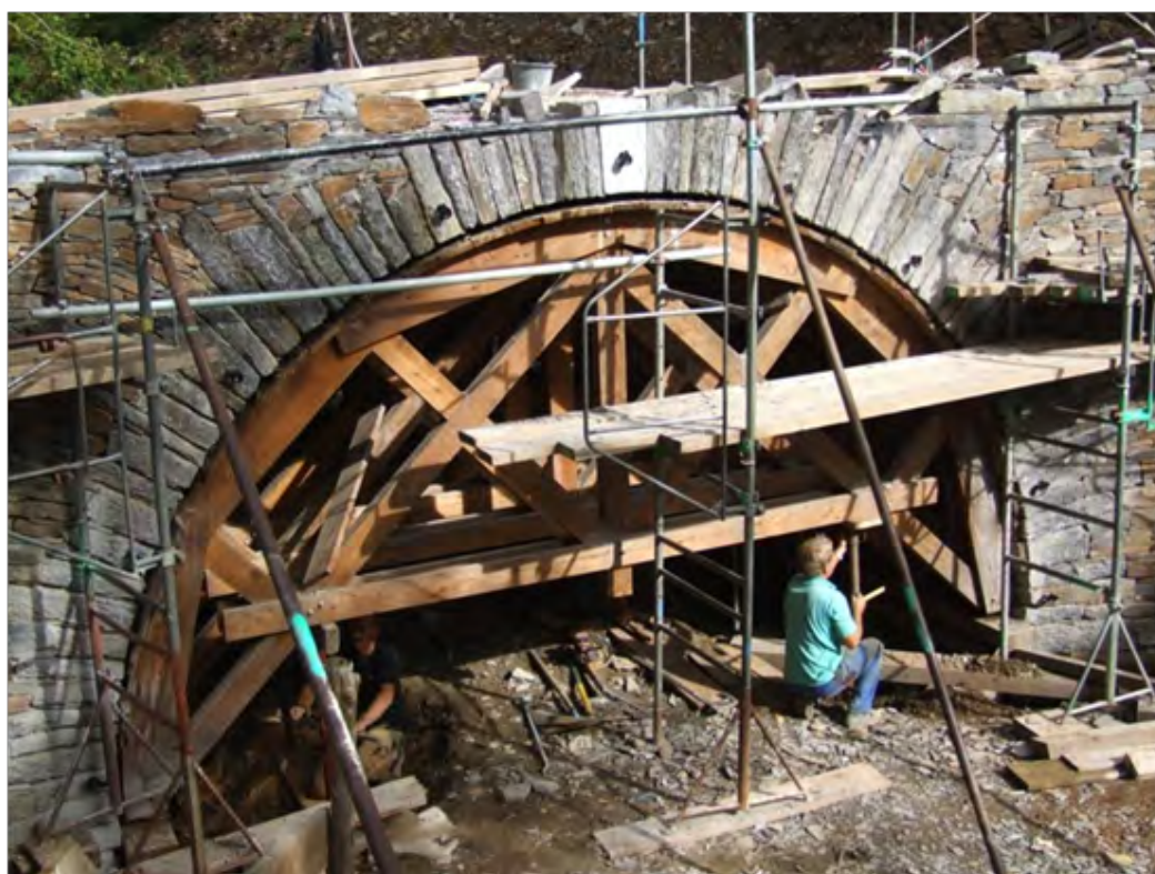
PEDRA: Reconstruction du pont de Chaldecoste, Lozère, France, ABPS et SETRA, 2011. (Photo ABPS)
