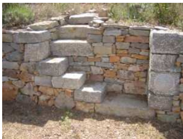
Escalier inclus dans une restanque (Toulon, Var, 83)
