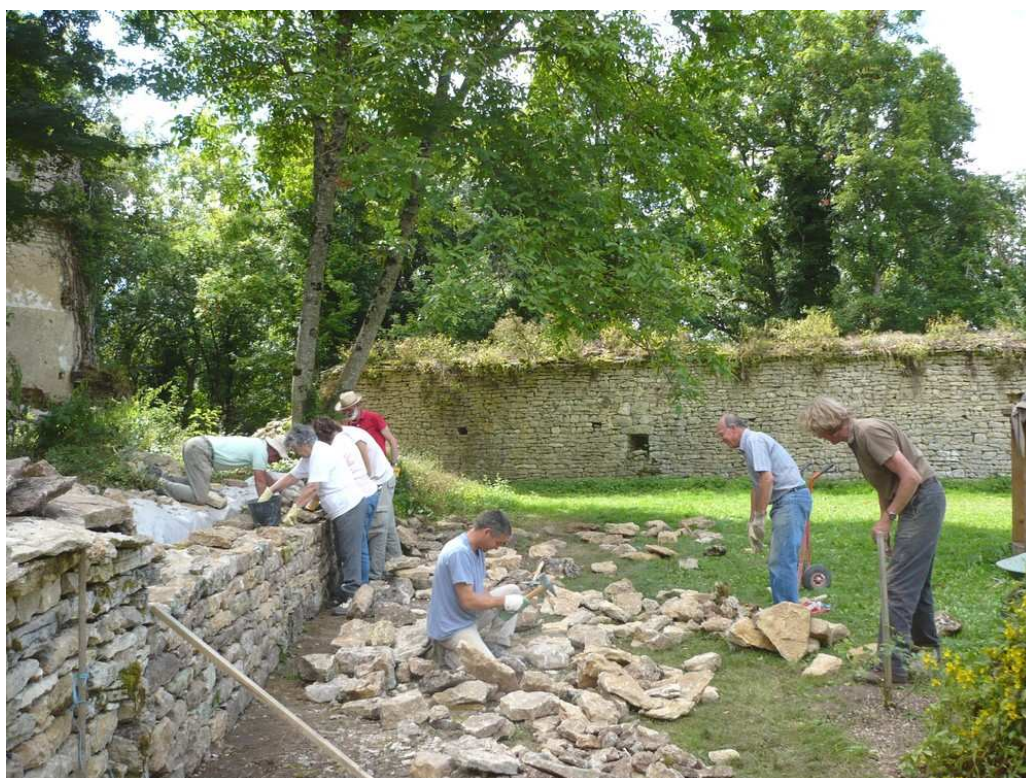
Restauration mur en pierre sèche Montfort (Gers, 32)
