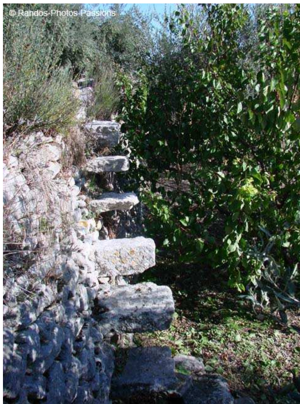
Escalier volant (Var, 83)
