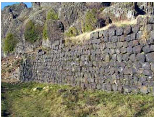
Mur de soutènement fait de section d'orgues
