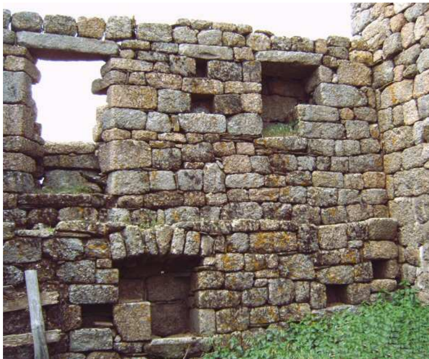
Parement intérieur d'une ancienne maison en granite (Drôme, 26)
