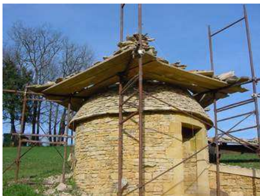
Couronnement des échafaudages (Village de vacance Langlade, Gard, 30)
