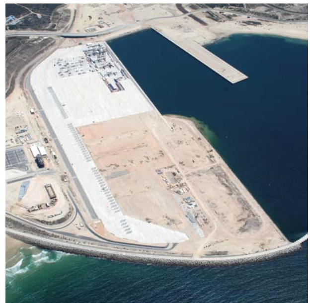
AFRIQUE DU SUD - Coega Port de Ngqura
