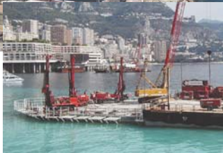
MONACO - Port de la Condamine Traitements sous caisson
