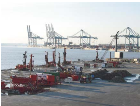
BELGIQUE - Anvers Reprise en sous-oeuvre d'un quai
