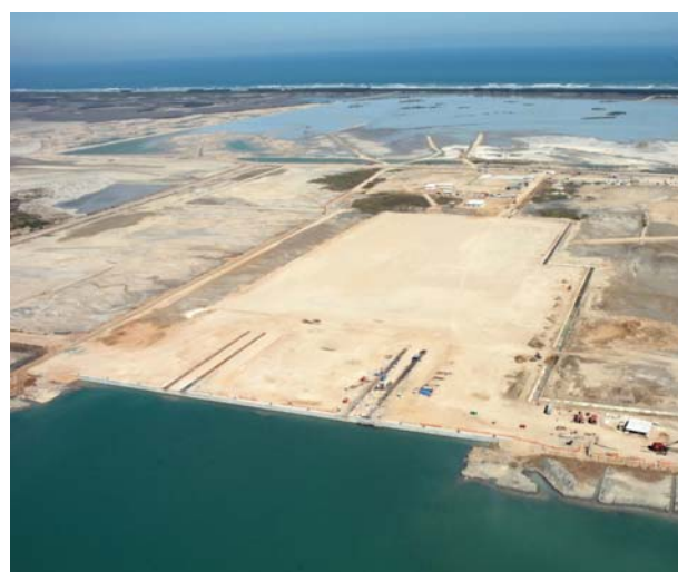
MEXIQUE - Altamira Terminal de construction de plateformes pétrolières
