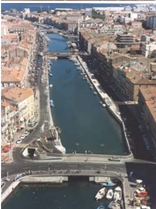
FRANCE - Sète Parking sous canal
