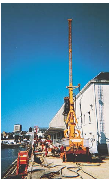
FRANCE - Concarneau Reprise en sous-oeuvre d'un quai
