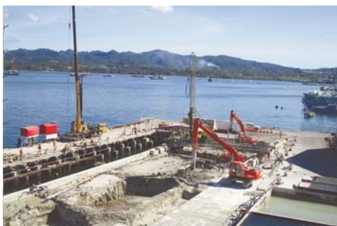
FIDJI - Fidji Island Réhabilitation d'un mur de quai
