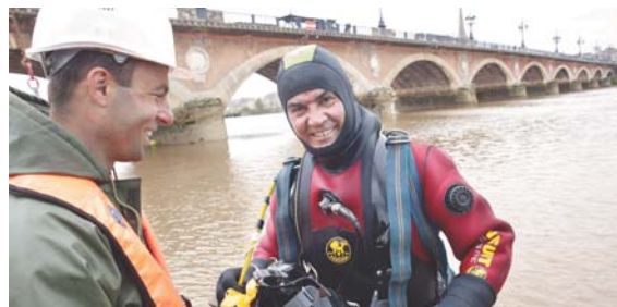
FRANCE - Bordeaux - Pont de Pierre Confortement
