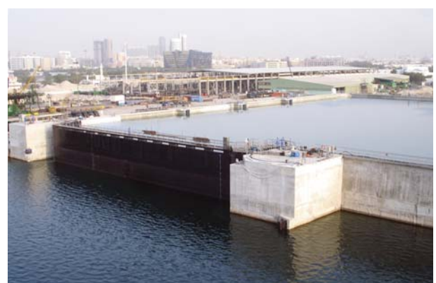
EMIRATS ARABES UNIS - Dubai - Safina Dry Dock Cale sèche de 140 m x 70 m
