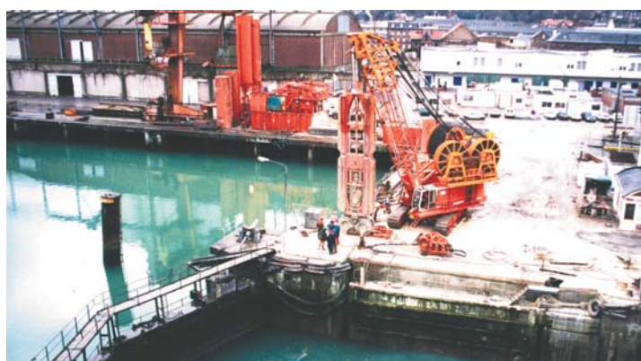
FRANCE - Dieppe Elargissement et approfondissement de l'écluse
