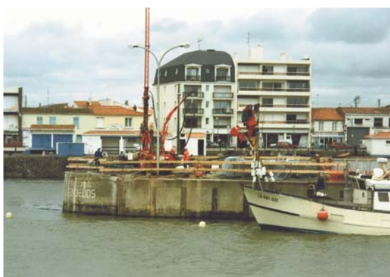
FRANCE - Saint-Gilles-Croix-de-Vie Confortement du musoir
