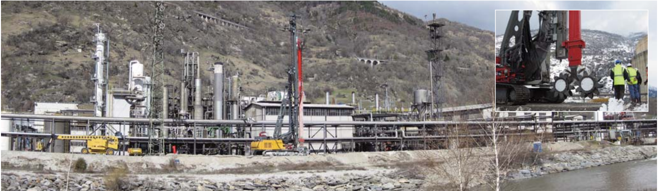
SUISSE - Viège Paroi étanche pour le renforcement des digues du Rhône
