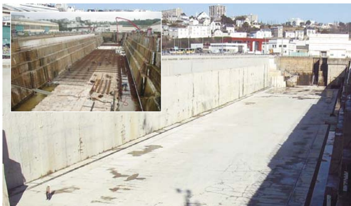
FRANCE - Brest - Forme de Radoub n°1 Agrandissement et modernisation
