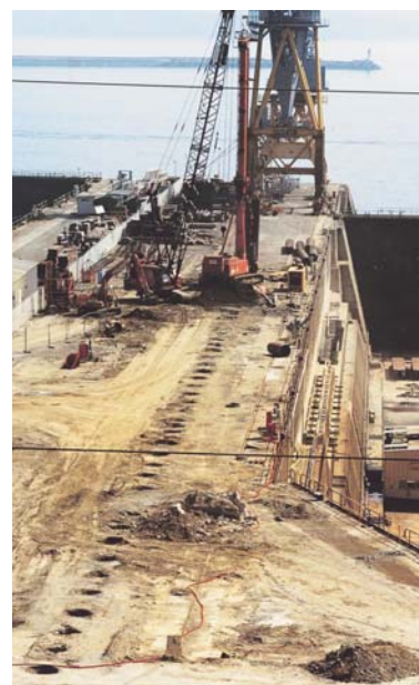
FRANCE - Dunkerque Ecluse Charles de Gaulle Reprise en sous-oeuvre
