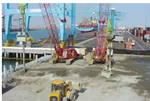
ETATS-UNIS - Los Angeles Réhabilitation d'un mur de quai
