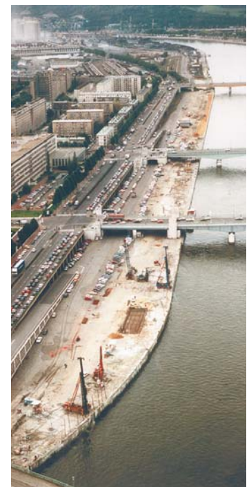
FRANCE - Rouen Rénovation des quais
