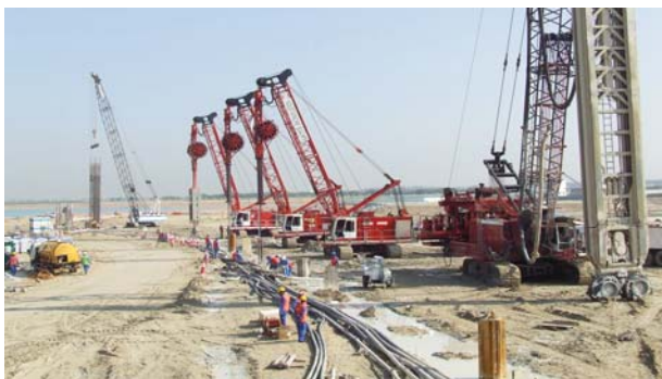
EMIRATS ARABES UNIS - Abu Dhabi - Al Raha Beach 12 km de quai en paroi moulée
