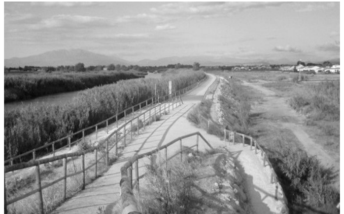
PHOTO 1 : DIGUE AVEC VOIE VERTE - VUE VERS L'AMONT
