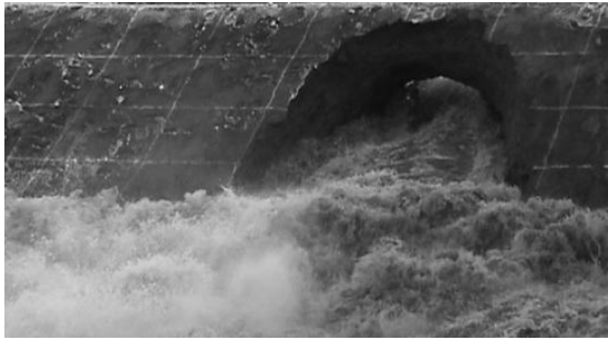
FIGURE 3 : RENARD DANS LA DIGUE HOMOGÈNE
