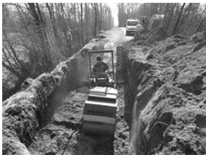
FIGURE 18 : REMBLAIEMENT ET COMPACTAGE D'UN FONTIS
