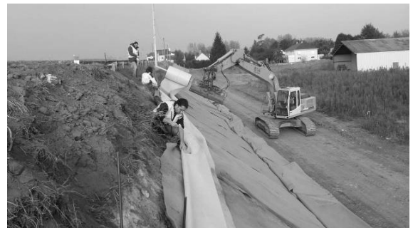
FIGURE 5 : DÉROULAGE ET FIXATION DES BANDES CAPTEUR SUR LE SYSTÈME DE FILTRATION GEOTEXTILE
