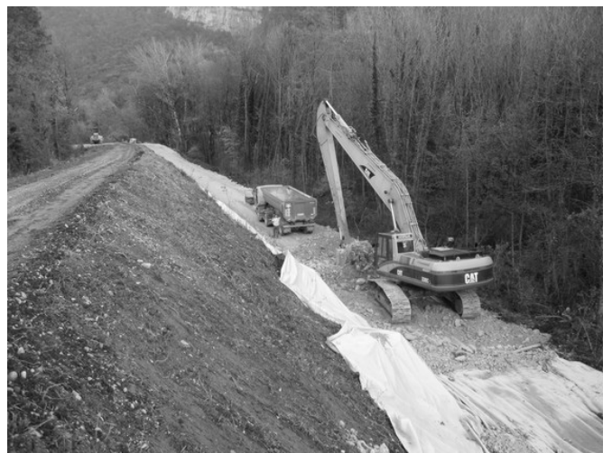
FIGURE 11 : PISTE EN REMBLAI 0/400
