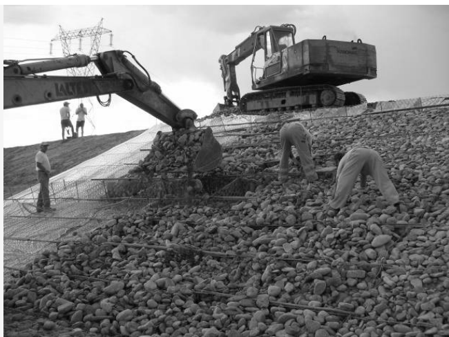
FIGURE 5 : LE DEVERSOIR EN CONSTRUCTION
