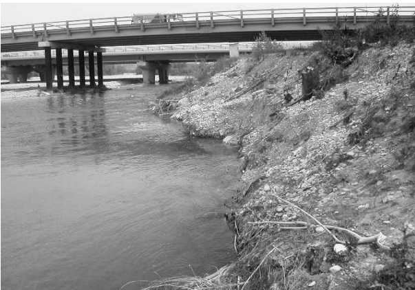
PHOTO 4 : ETAT DES LIEUX DE LA PROTECTION DE LA DIGUE AVANT TRAVAUX - 2003
