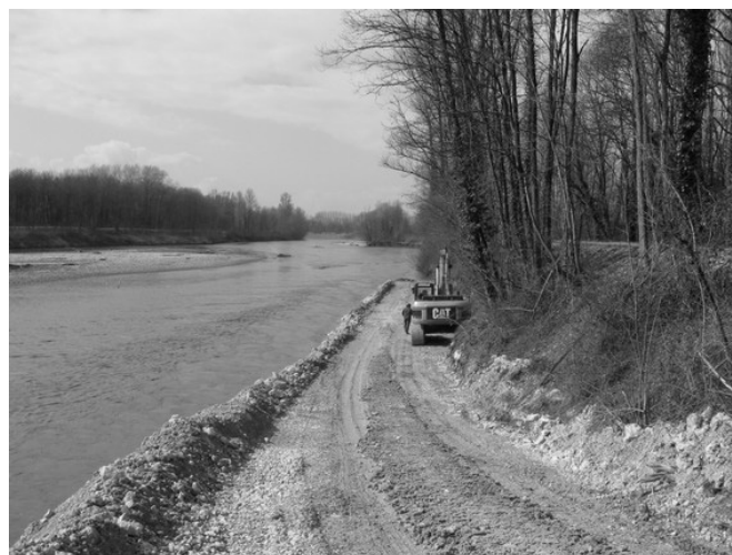
FIGURE 3 : BANQUETTE CIRCULABLE EN PIED DE DIGUE
