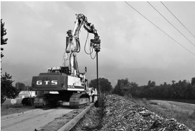
FIGURE 11 : MATÉRIEL ADAPTÉ À UN SITE EXIGU
