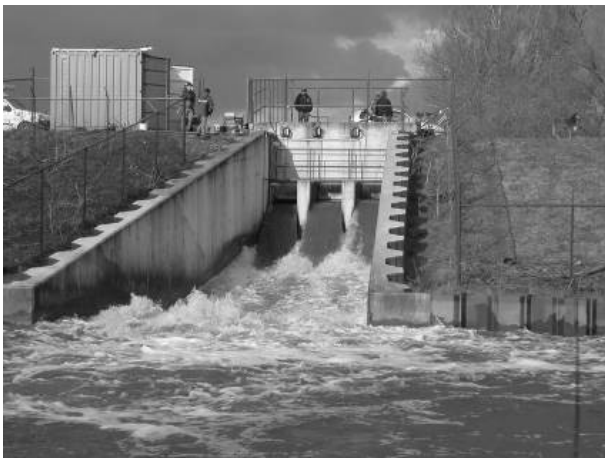
PHOTO 3: OUVRAGE D'ENTRÉE DU PROJET PILOTE « LIPPENBROEK »
