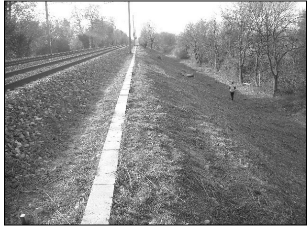
PHOTO 1 : VUE GENERALE DU REMBLAI D'ARLES
