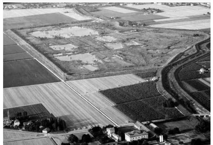
FIGURE 8 : LE BASSIN ECRETEUR EN 2012
