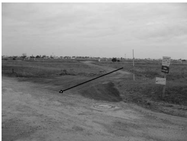
FIGURE 10 : ACCÈS AU PORT INTERROMPANT LA DIGUE EST DU LAY (LA FLÈCHE MATÉRIALISE L'ENTRÉE DE L'EAU) - LA FAUTE-SUR-MER (85)
