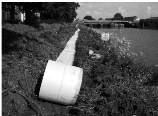
FIGURE 10 : DÉROULAGE DE LA BANDE CAPTEUR DANS LA TRANCHÉE INFÉRIEURE
