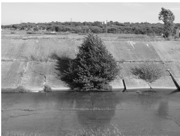
FIGURE 4: BASCULEMENT DES DALLES
