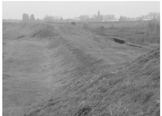
FIGURE 6 : LE DEVERSOIR EN GABIONS VEGETALISE EN 2012
