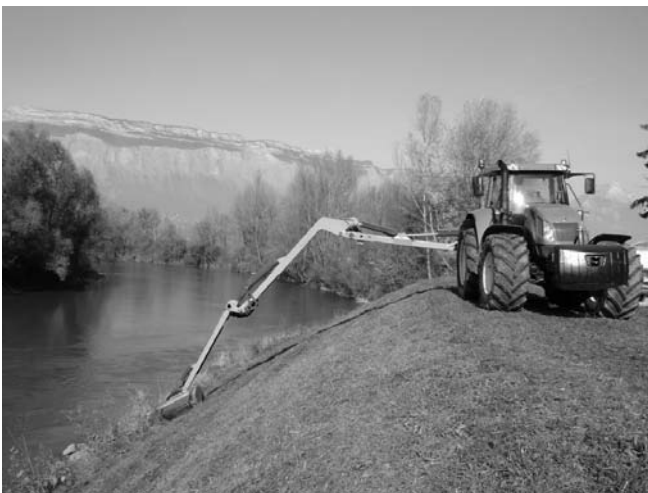
FIGURE 2: ENTRETIEN PAR EPAREUSE DU TALUS DE DIGUE
