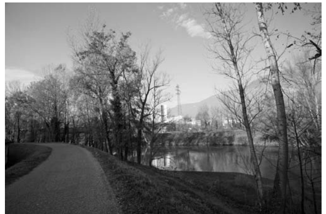
FIGURE 2 : DIGUE DE L'ISÈRE AU DROIT DU DOMAINE UNIVERSITAIRE DE GRENOBLE
