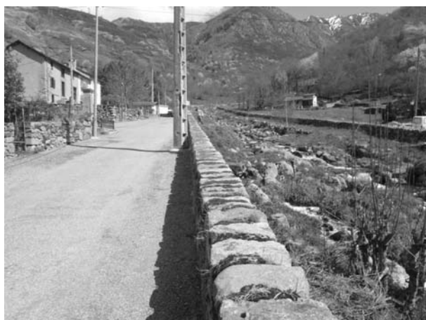
FIGURE 5 : CRÊTE DE LA DIGUE RIVE DROITE DE MÉRENS-LES-VALS
