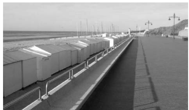
PHOTO 6: MURET SOUS FORME DE BANQUE À DE HAAN
