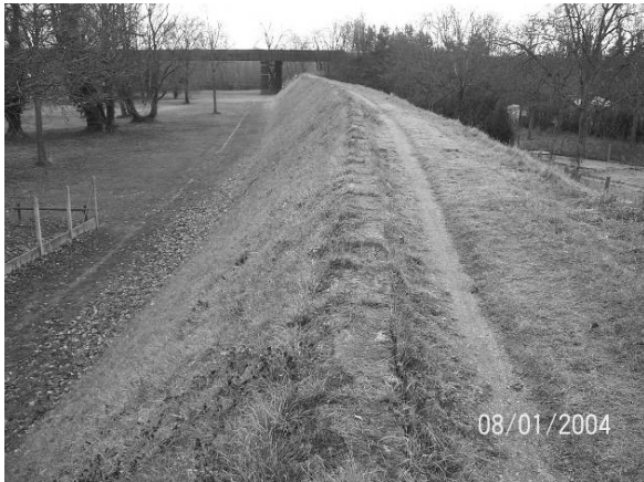
PHOTO 3: ETAT DES LIEUX DE LA DIGUE DE MOULINS AVANT TRAVAUX
