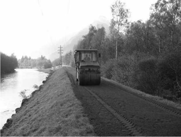
FIGURE 2: RÉFECTION D'UNE PISTE EN FRAISAT RECYCLÉ
