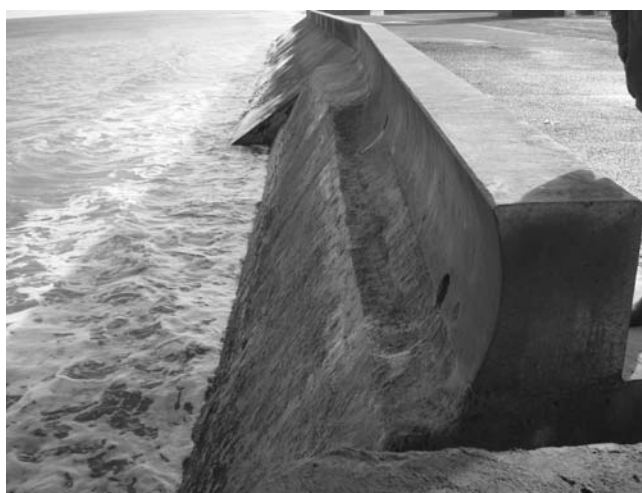
FIGURE 3 : RECONSTRUCTION DU PARAPET ET REPRISE DU PERRÉ DE LA DIGUE D'ASNELLES
