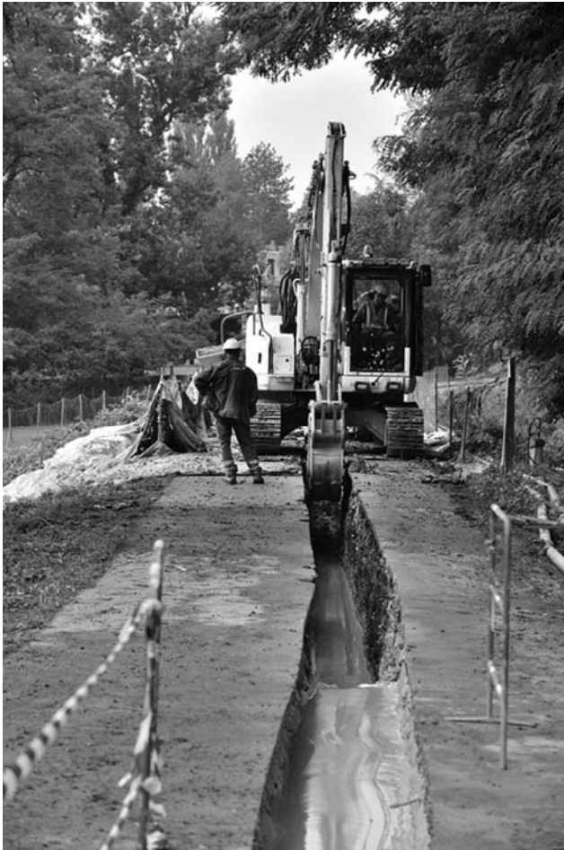
FIGURE 5 : ATELIER DE CREUSEMENT EN COURS
