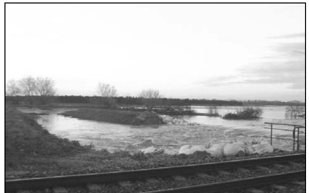
PHOTO 2 : BRECHE DANS LE CAVALIER DE PROTECTION DE LA TREMIE « MAS DE TEISSIER » (2003)
