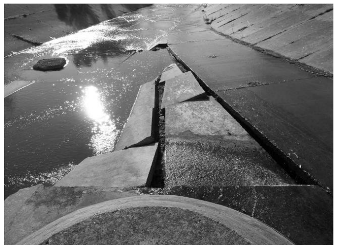
FIGURE 8: DÉMANTÈLEMENT ET BASCULEMENT DES DALLES SOUS CAVÉES
