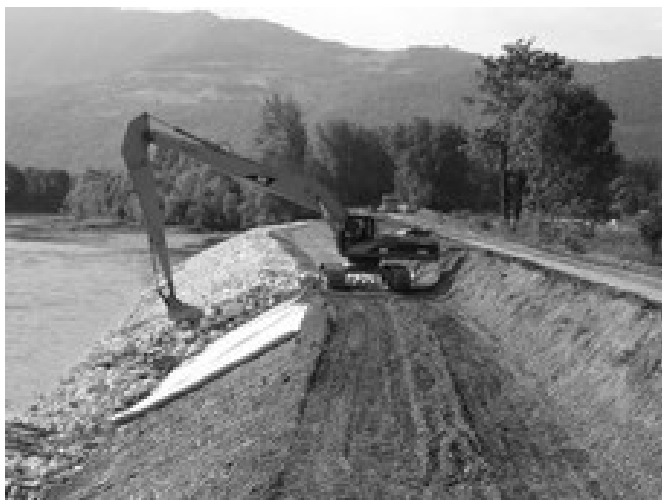
FIGURE 5 : ENROCHEMENT D'UNE BANQUETTE
