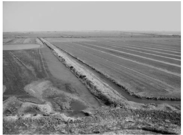
FIGURE 1 : VUE AÉRIENNE DE DIGUES ET DE LEUR ENVIRONNEMENT DE TERRES BASSES (SOURCE : SÉCURITÉ CIVILE)
