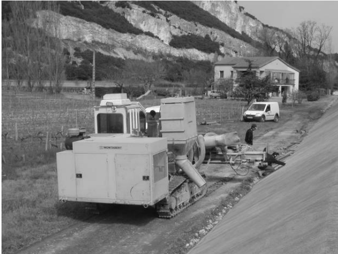
PHOTO 2 : TRAVAUX DE FORAGE DES BARBACANES DANS LES DALLES BÉTON DU TALUS AVAL-DIGUE DE VIVIERS
