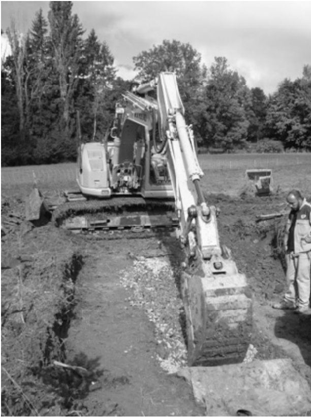
FIGURE 2. DEBUT DE DEBLAIEMENT DE LA TRANCHÉE T2.
