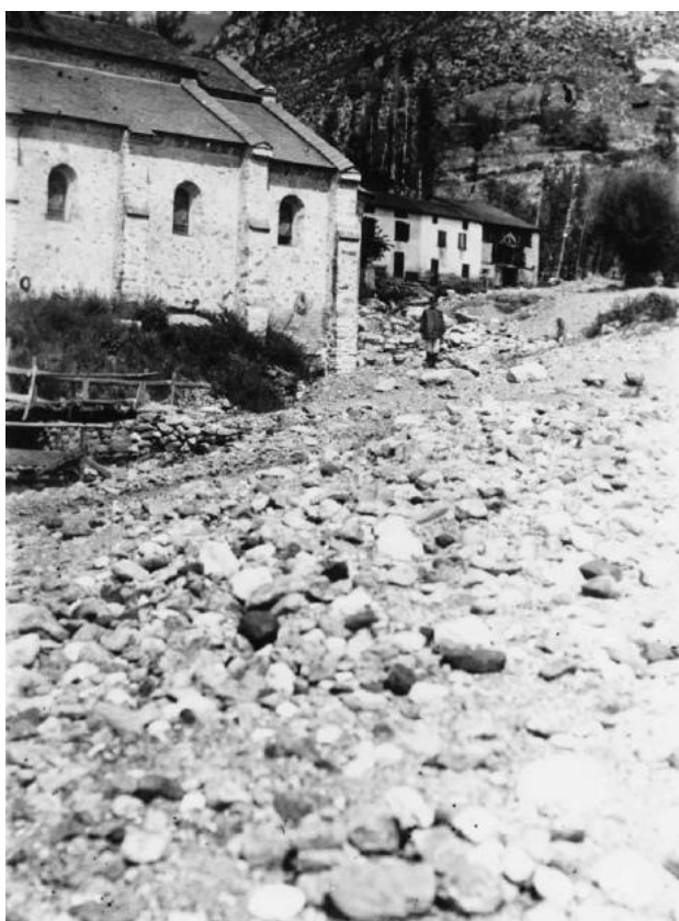
FIGURE 1 : LES DÉPÔTS DE CRUE À L'AMONT DE L'ÉGLISE DE VERDUN EN 1875 (ARCHIVES RTM) [1]
