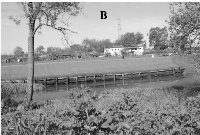
FIGURE 6: A : ZONE ENDOMMAGÉE AVANT TRAVAUX ; B : IMMEDIATEMENT APRÈS RENOVATION VIA REMISE EN PLACE DU SOL TRAITÉ À LA CHAUX.
