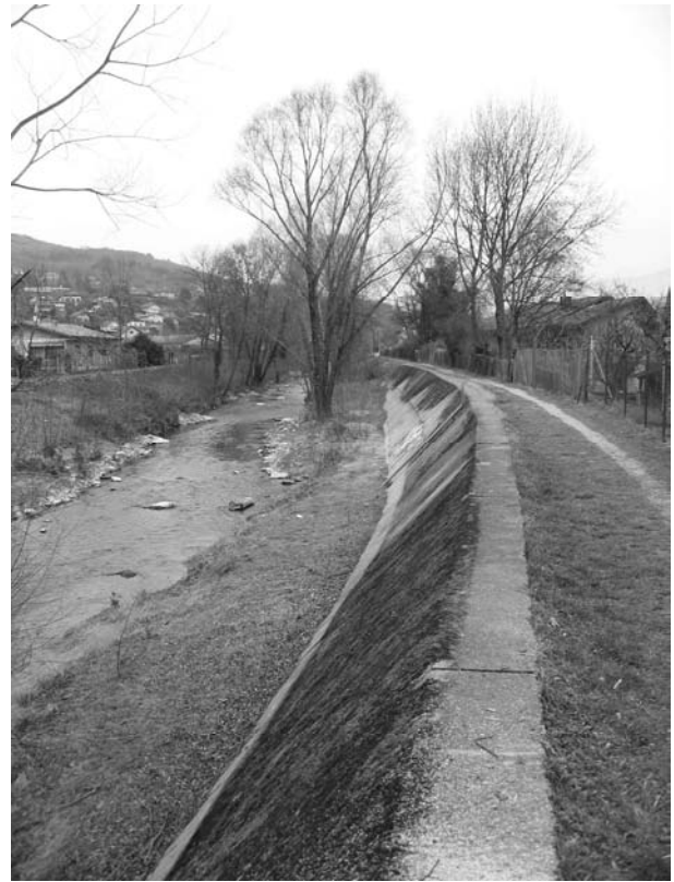
FIGURE 1 : CONFORTEMENT DU TALUS AMONT DE LA DIGUE RIVE GAUCHE
