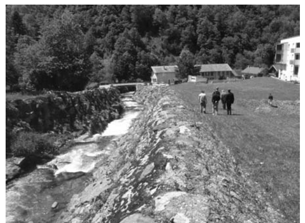
FIGURE 11 : DIGUES (VUE RIVE DROITE) DU COUGNETS À COUFLENS
