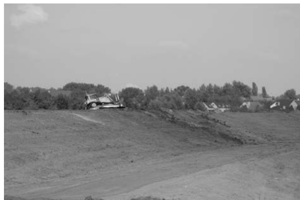
PHOTO 1: TRAVAUX DE DIGUES
