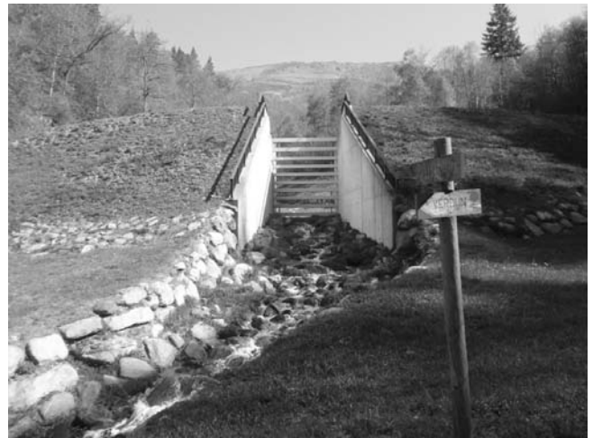
Figure 15 : Plage de dépôt en amont de Verdun
