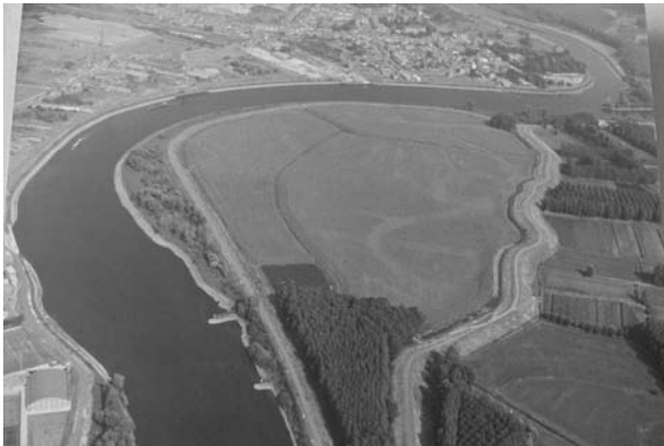
PHOTO 2: PHOTO AÉRIENNE DE LA ZONE D'INONDATION CONTRÔLÉE « BOVENZANDEN »
