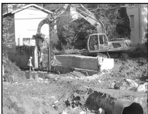
FIGURE 6 : MISE EN ŒUVRE DE LA PAROI BERLINOISE
