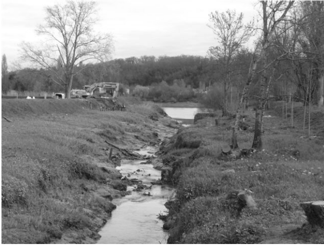
FIGURE 2: VUE D'ENSEMBLE DES RIVES DE L'ESTEY D'EYRANS AVANT TRAVAUX
