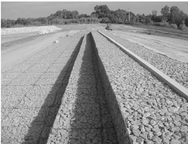
FIGURE 7 : ÉCHANCRURE DU DÉVERSOIR DE LUNEL EN GABIONS
