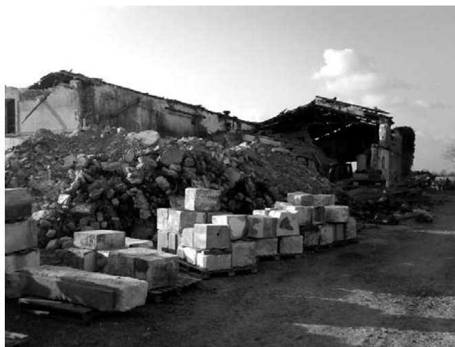
FIGURE 5: DÉCONSTRUCTION DE LA CAVE COOPÉRATIVE
