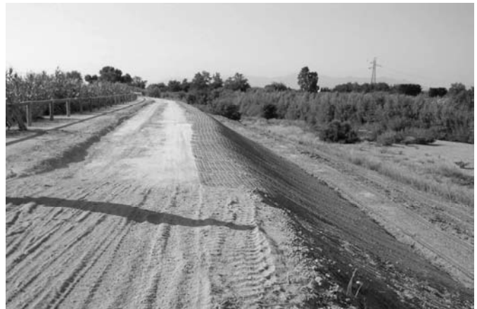
PHOTO 2 : SÉCURISATION DIGUE RG : TRAVAUX REALISES EN JUILLET 2012
