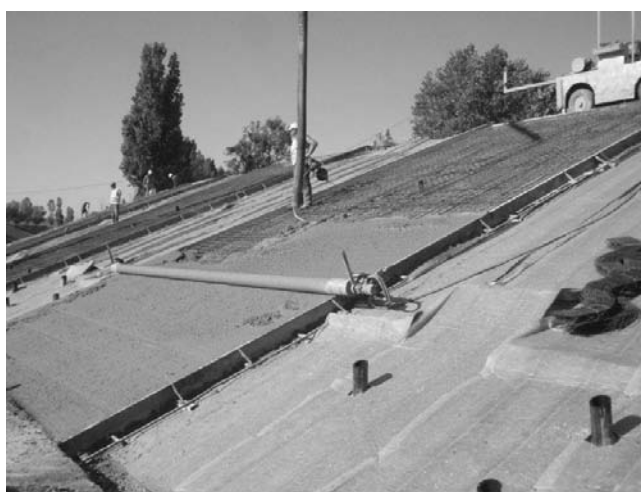
FIGURE 14: BÉTONNAGE DU PAREMENT INCLINÉ DES DIGUES AVEC LE DISPOSITIF HORPEND
