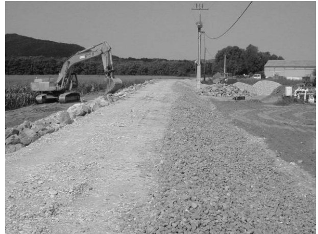
PHOTO 9 : DIGUE D'ETOILE-SUR-RHÔNE – MISE EN OEUVRE DES ENROCHEMENTS CÔTÉ FLEUVE
