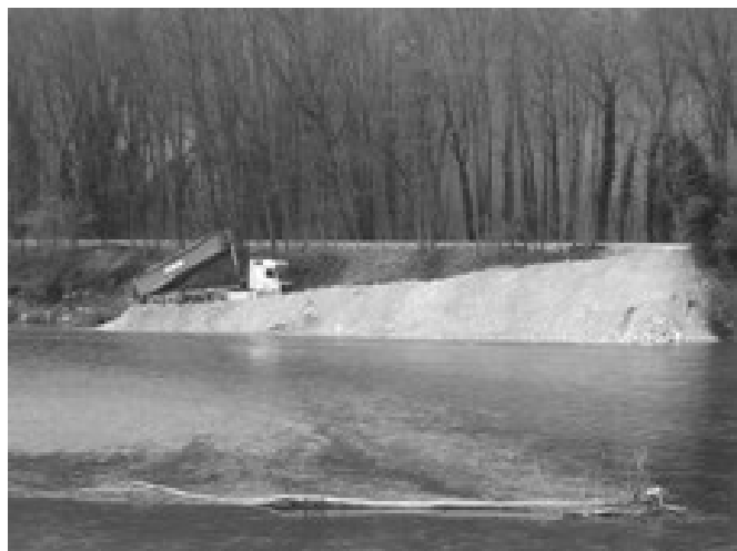
FIGURE 2 : RAMPE D'ACCÈS AU PIED DE DIGUE
