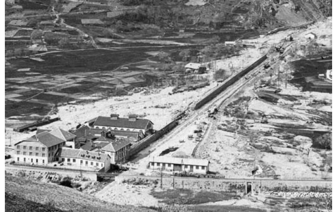
FIGURE 3. BRÈCHES DANS LA DIGUE RIVE DROITE DU FURNEL À L'ARGENTIÈRE-LA-BESSÉE (05) EN 1928 (FOND M. HENRY).
