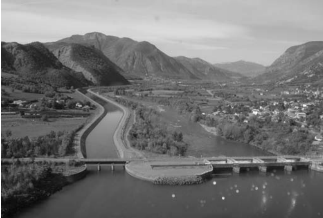
FIGURE 7: VUE DU CANAL D'AMENÉE D'EAU À L'USINE HYDROÉLECTRIQUE DE CURBANS (EDF), À GAUCHE, ET DE LA DURANCE, À DROITE.
