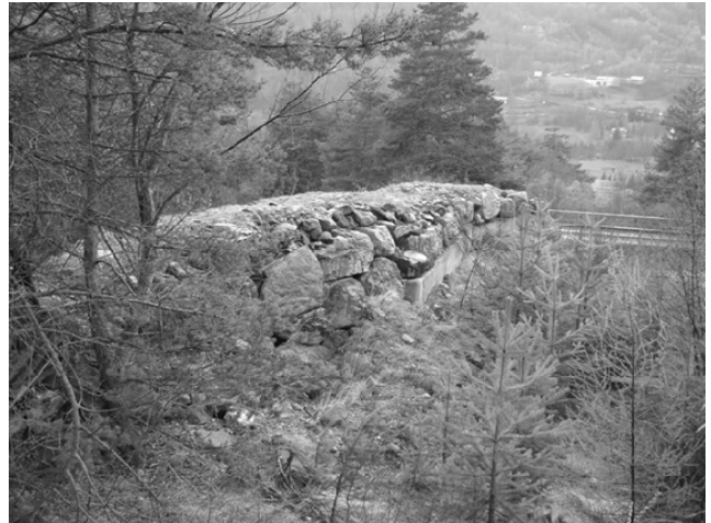
FIGURE 4. TRONÇON DE DIGUE RÉHAUSSÉE 1-RG. PAREMENT COMPOSITE COTE TORRENT (BÉTON ET ENROCHEMENTS).
