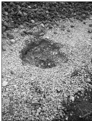
A – Résultat d'effondrement de terrier
