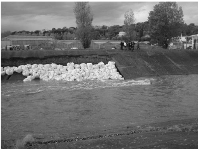
FIGURE 11 : MISE EN PLACE DE « BIG BAG » APRÈS LA CRUE
