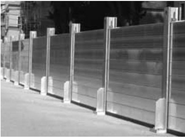
PHOTO 9: PROTECTION ANTI-INONDATIONS TEMPORAIRE UTILISÉ À OSTENDE
