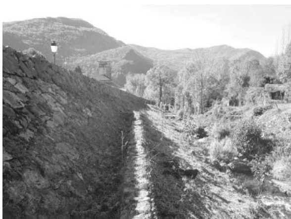
FIGURE 4 : PAREMENT CÔTÉ TORRENT DE LA DIGUE DE VERDUN
