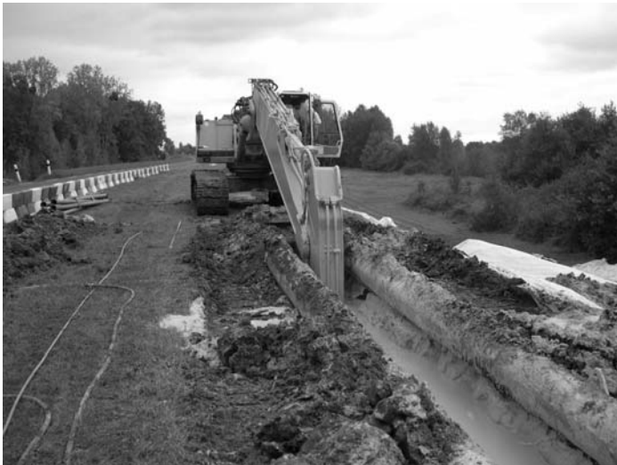
FIGURE 7 : RENFORCEMENT PAR MISE EN ŒUVRE D'UNE PAROI MOULÉE (VOILE BENTONITE/CIMENT) À LIMERAY EN 2010
