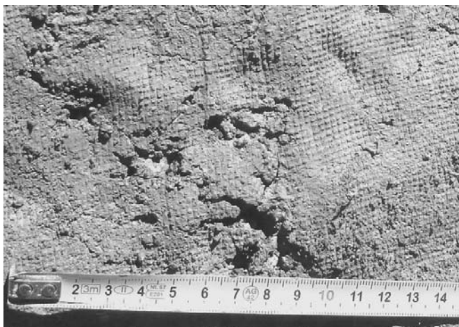
FIGURE 10. TRANCHÉE T5. INTERFACE SOL/GÉOTEXTILE VUE DEPUIS L'AVANT.
