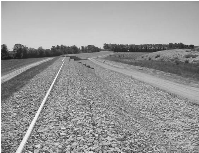
FIGURE 5 : DÉVERSOIR DE LUNEL EN MATELAS DE GABIONS
