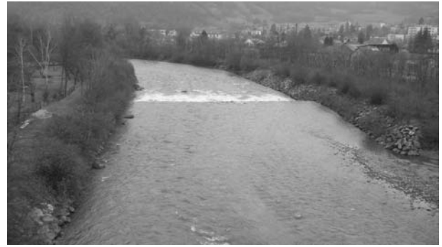
FIGURE 3: VUE DES OUVRAGES D'ENDIGEMENT A VIZILLE DEPUIS LE PONT DE LA RN 85
