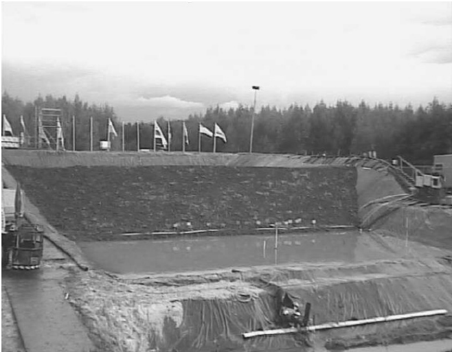
FIGURE 4: VUE D'UNE DIGUE TEST AU COURS D'UN ESSAI IJKDIJK DE RUPTURE PAR ÉROSION INTERNE
