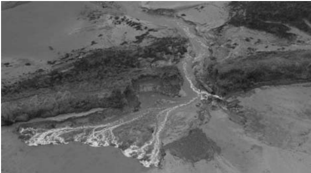
FIGURE 7 : DEUX STADES DE FORMATION D'UNE BRÈCHE PAR SURVERSE : À GAUCHE, AFFOUILLEMENT PONCTUEL CÔTÉ TERRE, À DROITE BRÈCHE TOTALE - BATZ-SUR-MER (44) [CRÉDIT PHOTOGRAPHIQUE DREAL PAYS DE LA LOIRE / DDTM 85 / J. MORNET]
