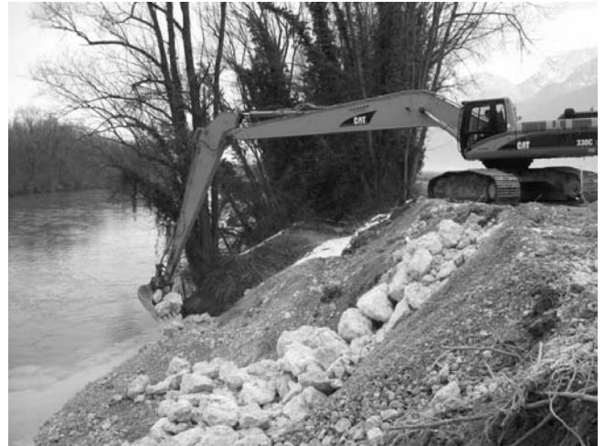
FIGURE 3: RÉPARATION D'UN GLISSEMENT PONCTUEL
