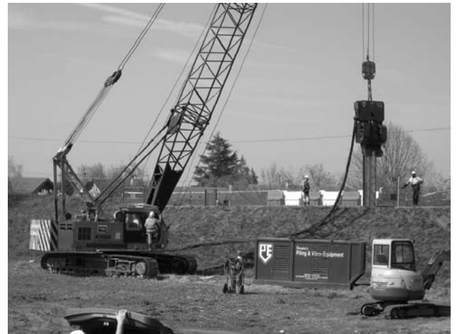
FIGURE 6 : RENFORCEMENT PAR MISE EN ŒUVRE DE PALPLANCHES VIBRO-FONCÉES À ST PÈRE-SUR-LOIRE EN 2011
