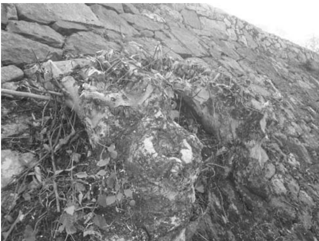
FIGURE 12 : SOUCHE SUIVIE SUR LA DIGUE DE VERDUN
