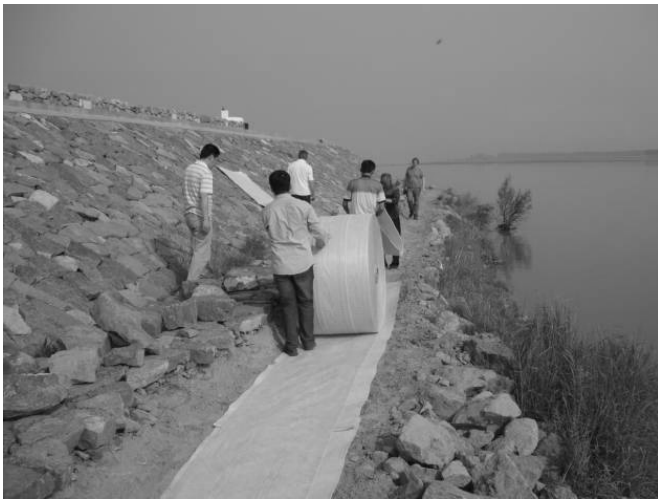
FIGURE 15 : POSE DE LA BANDE CAPTEUR COMPOSITE SUR LA BERGE INTERMÉDIAIRE DE L'ÉPERON 24.
