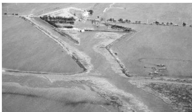
FIGURE 7 : VUE D'HÉLICOPTÈRE DE LA DIGUE NORD DES MIZOTTES SUR LA COMMUNE DE CHARRON ET DU CANAL DU CURÉ, AU LENDEMAIN DE LA TEMPÊTE XYNTHIA (SOURCE : SÉCURITÉ CIVILE)
