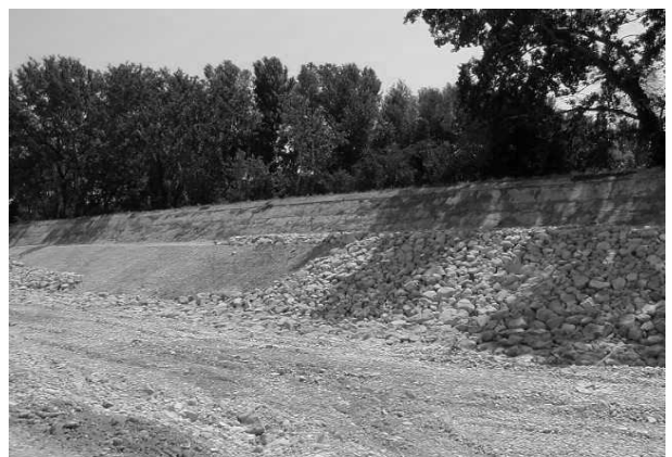
PHOTO 5 : TRAVAUX DE MISE EN ŒUVRE DE LA PROTECTION, EN, COURS DE RÉALISATION
