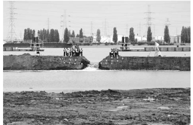
PHOTO 11: ESSAIS DE CROISSANCE D'UNE BRÈCHE À LILLO
