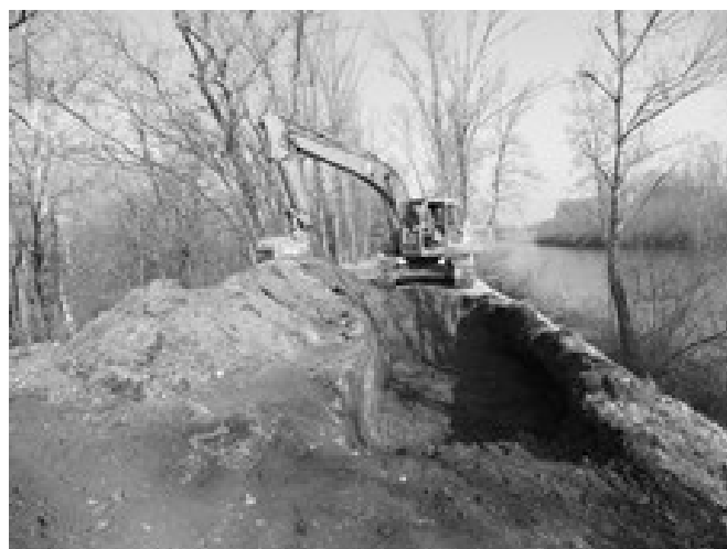
FIGURE 17 : TERRASSEMENT D'UN FONTIS
