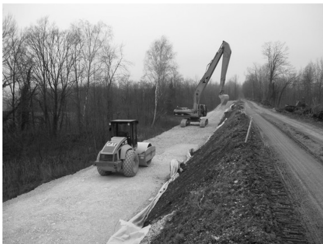
FIGURE 12 : MISE EN ŒUVRE DU REMBLAI DRAINANT
