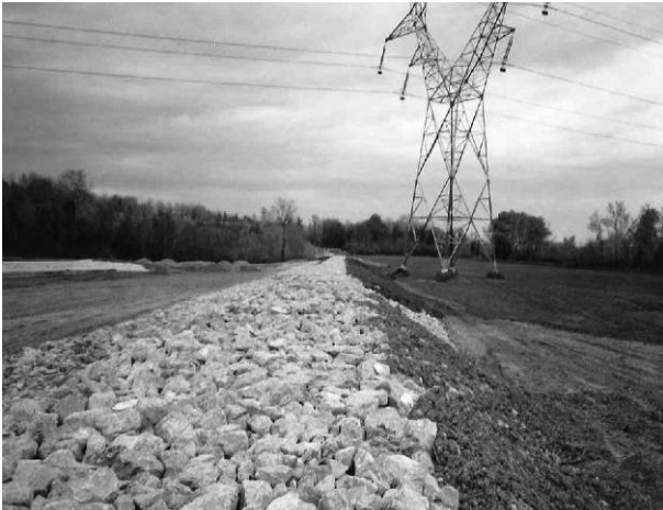
PHOTO 8 : DIGUE DE SAINT-JUST – DÉTAIL DE LA DIGUE CONFORTÉE
