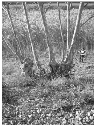
B – Arbre de grande hauteur dans le talus du remblai
