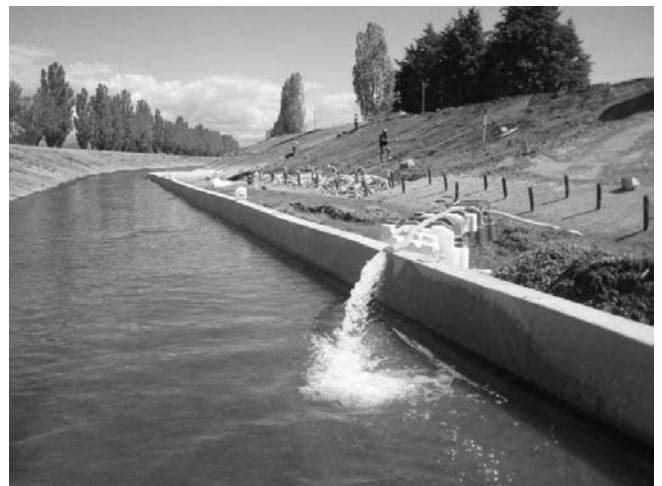
FIGURE 12: BATARDEAU EN BÉTON EXTRUDÉ DÉVIAIT LES ÉCOULEMENTS DU REYRAN
