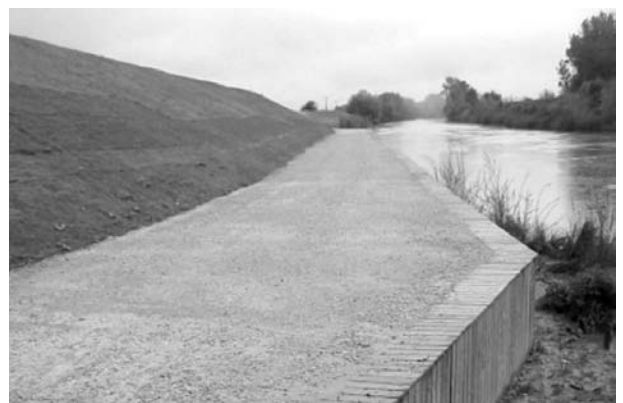
FIGURE 8: PHOTO DU CONFORTEMENT EN PLACE
