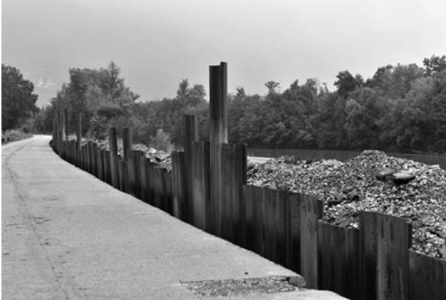
FIGURE 10 : RIDEAU DE PALPLANCHES EN COURS DE MISE EN ŒUVRE
