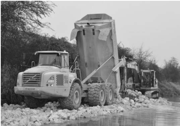
FIGURE 4 : MISE EN PLACE D'UNE PROTECTION DE PIED DE LEVÉE PAR ENROCHEMENT EN 2011
