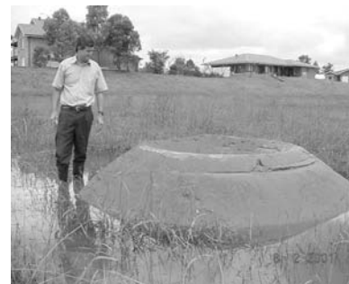
FIGURE 7 : TUMULUS CAUSÉ PAR L'ÉROSION RÉGRESSIVE
