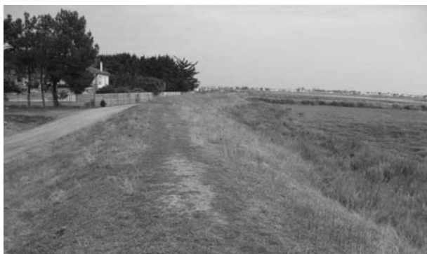
FIGURE 4 : DIGUE EN TERRE - LA FAUTE-SUR-MER (85)
