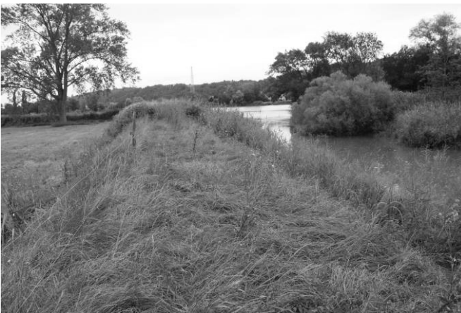
FIGURE 7: OUVRAGE RENOVÉ À L'AIDE DU TRAITEMENT À LA CHAUX ET REVEGETALISÉ APRÈS 1 AN (ÉTÉ 2012)
