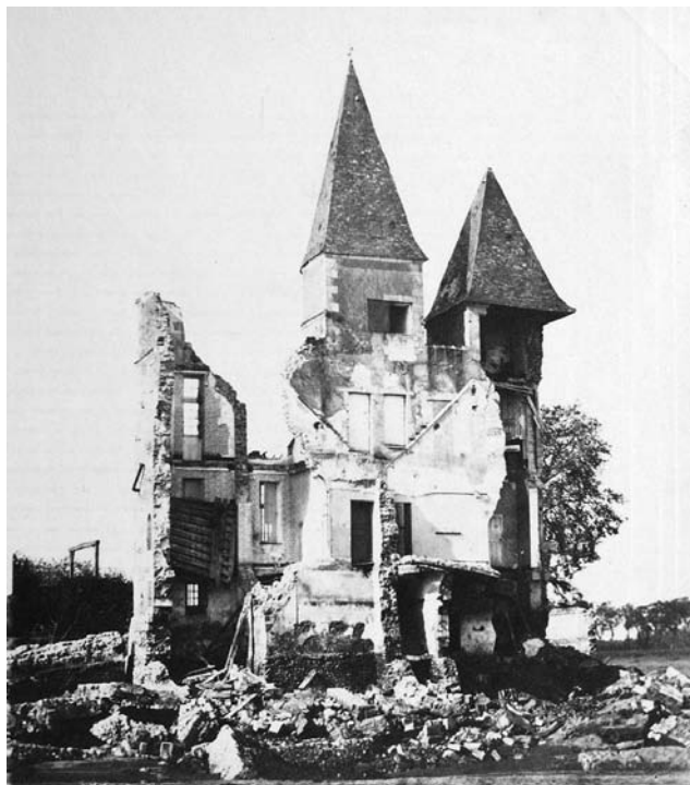
FIGURE 3 : - PHOTO DU CHÂTEAU DE L'ISLE EN 1866 (FOND MUGETTE RIGAUD)
