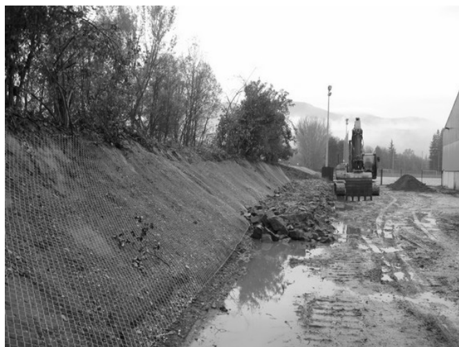
FIGURE 15 : POSE DE LA NAPPE DE GRILLAGE
