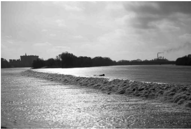
FIGURE 6 : DÉVERSOIR LATÉRAL DU CANAL DE FUITE DE L'AMÉNAGEMENT DE LA CHUTE DE VALLABRÈGUES
