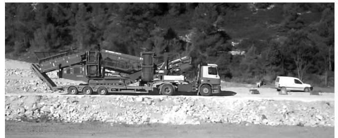
FIGURE 4: AMENÉE D'UNE UNITÉ MOBILE DE CONCASSAGE ET TRI
