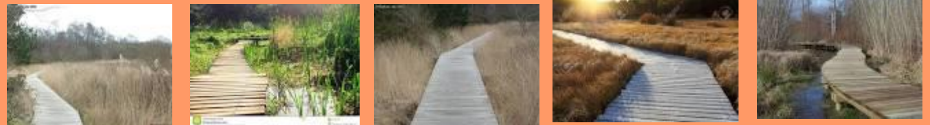
Platelages sur pilotis , une passerelle en bois, pour traverser une zone humide.
