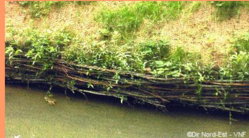
Fascines : Fagots de branches fixés par des pieux battus mécaniquement. C'est une protection de berge. Source : http://www.nordest.vnf.fr/spip.php?article3098
