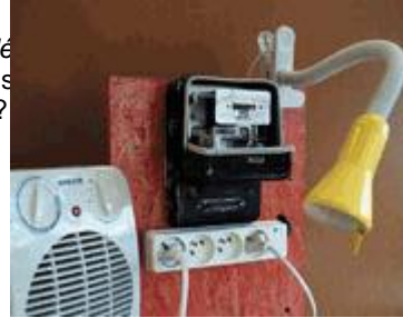
8. Conso-mètre énergie, puissance Allez savoir ce qui compte pour ce compteur très "branché"
