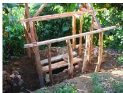
Latrines en cours de construction
