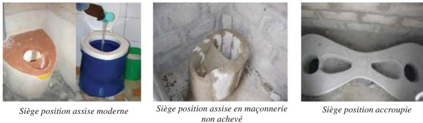
**Photo n° 1 : Types de latrines ECOSAN avec les différents design de cuvette/siège**
