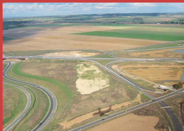
Les constructions de routes, aéroports... détruisent de grandes surfaces de sols (Roissy, France).
