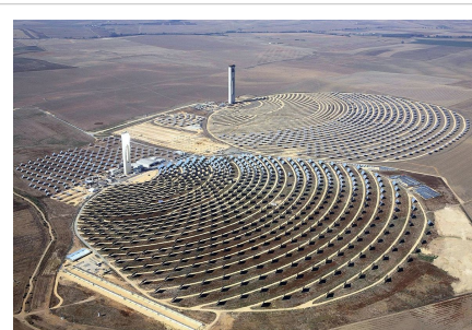
Source d'énergie renouvelable, les tours solaires thermiques utilisent le soleil comme ressource naturelle. Depuis la gauche : les tours solaires PS10 et PS20 en Espagne.
