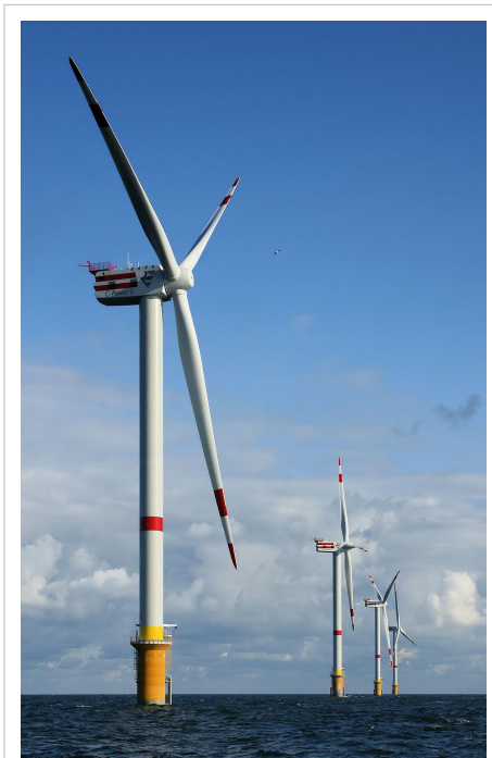
La ressource naturelle qu'est le vent alimente cette éolienne de 5MW dans un parc éolien à 28 km au large de la Belgique.
