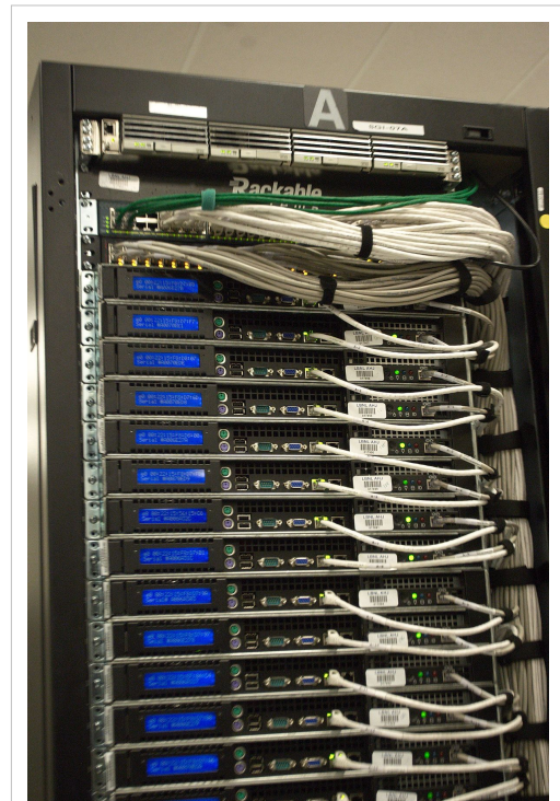
Centre de stockage des données
