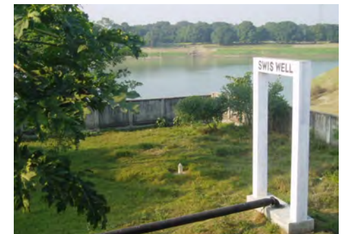
Figure 3. Puits d'infiltration construit sur les rives d'un fleuve au Bangladesh, permettant de contrôler la teneur en arsenic de l'eau fournie (Photo : A. Tuinhof)
