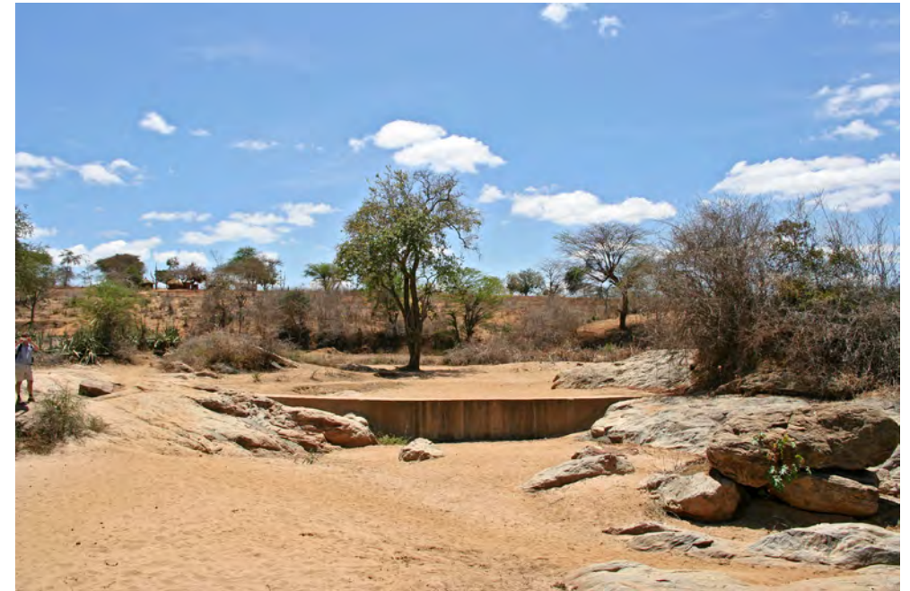
Figure 1: Exemple d'un barrage de sable destiné au stockage de l'eau, pendant la saison sèche ; district de Kitui
