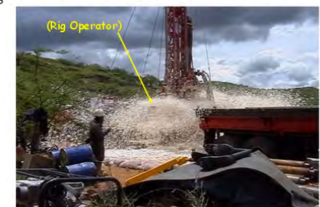
Figure 4 : Forage d'un puits profond au large diamètre
