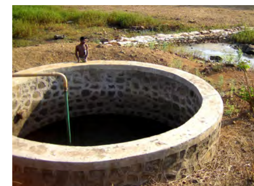
Figure 3 : Puits ouvert adjacent au déversoir de contrôle à Vanvasi, Inde (photo: MetaMeta)
