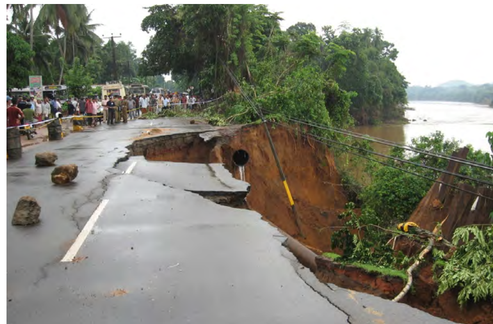
Figure 1 : Érosion de la berge de la rivière Kelani due à l'extraction du sable. Un conduit d'approvisionnement en eau à usage domestique situé sous la route a été endommagé et l'approvisionnement en eau de la ville a été perturbé pendant plusieurs jours. (Photo : Badra Kamaladasa, ministère de l'Irrigation du Sri Lanka)
