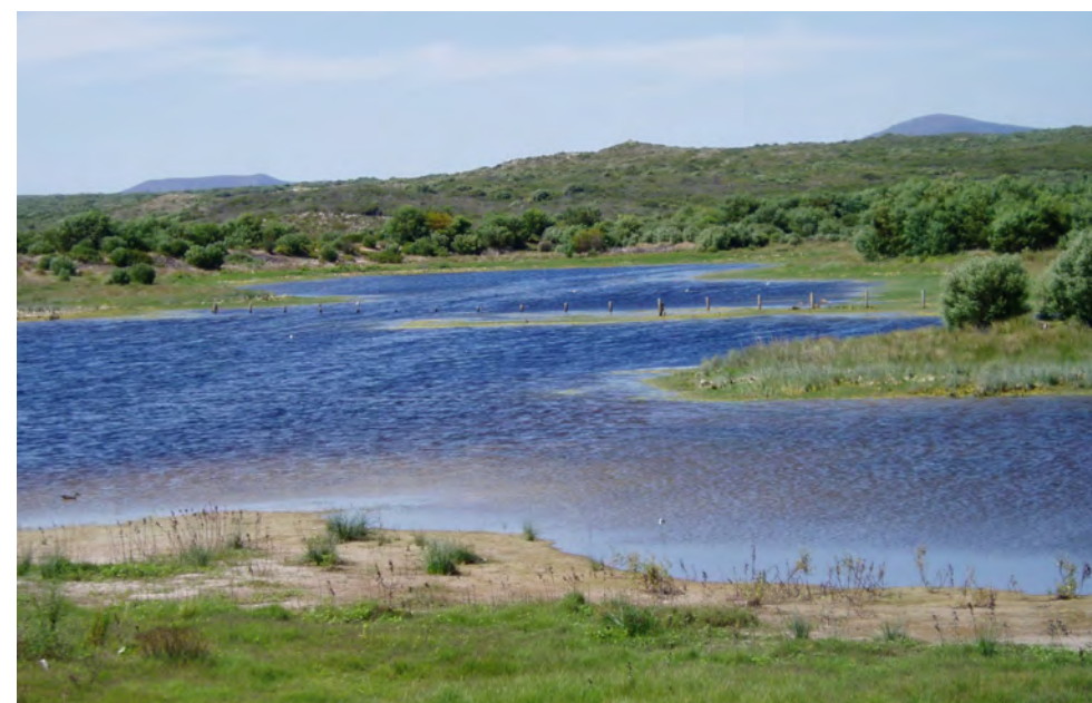
Figure 1 : Étangs d'infiltration dans les dunes à Atlantis, Afrique du Sud
