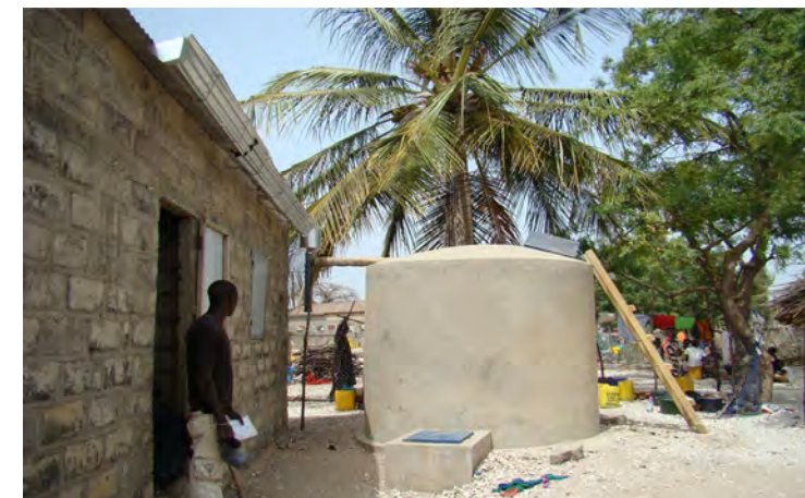
Figure 3 : Entretien d'un réservoir de collecte des eaux de pluie dans le village de Diogane
