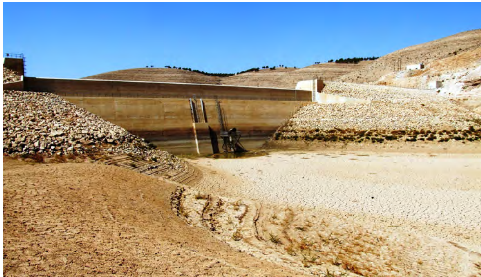
Figure 3 : L'accumulation de sédiments au fond du barrage de Wadi Wala a conduit à la fermeture du tuyau de sortie et du tuyau de prélèvement inférieur
