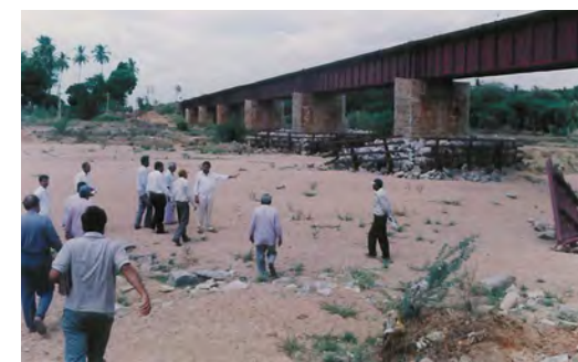
Figure 3 : Pont ferroviaire fréquemment réparé en raison de l'exploitation de sable sur la rivière Uttara Pinakini à Gauribidanur taluk, Karnataka, 2002. (Hemalatha, A.C. et coll. 2005)
