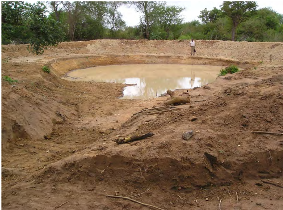
Figure 1 : Barrage de terre dit « Charco » (Source : E. Nissen-Petersen, 2006)
