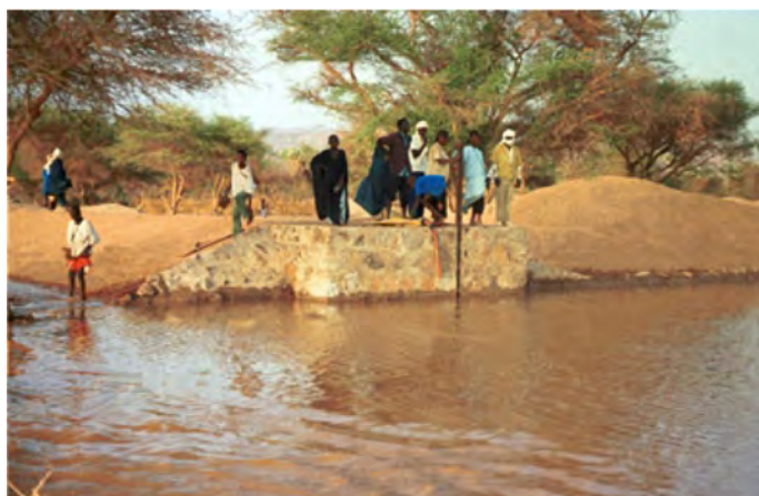
Figure 4 : Eaux de crue pénétrant dans le bassin d'infiltration
