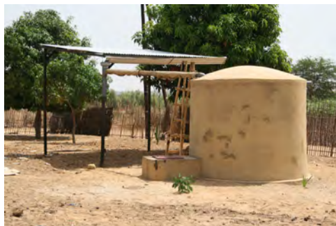
Figure 2 : Un hangar construit par l'organisation partenaire CCF, aucun toit n'étant adapté à la collecte des eaux de pluie.
