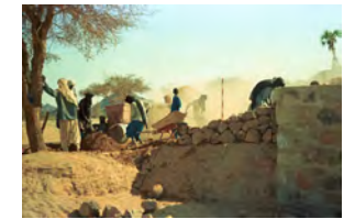
Figure 2: Des divers travaux de construction
