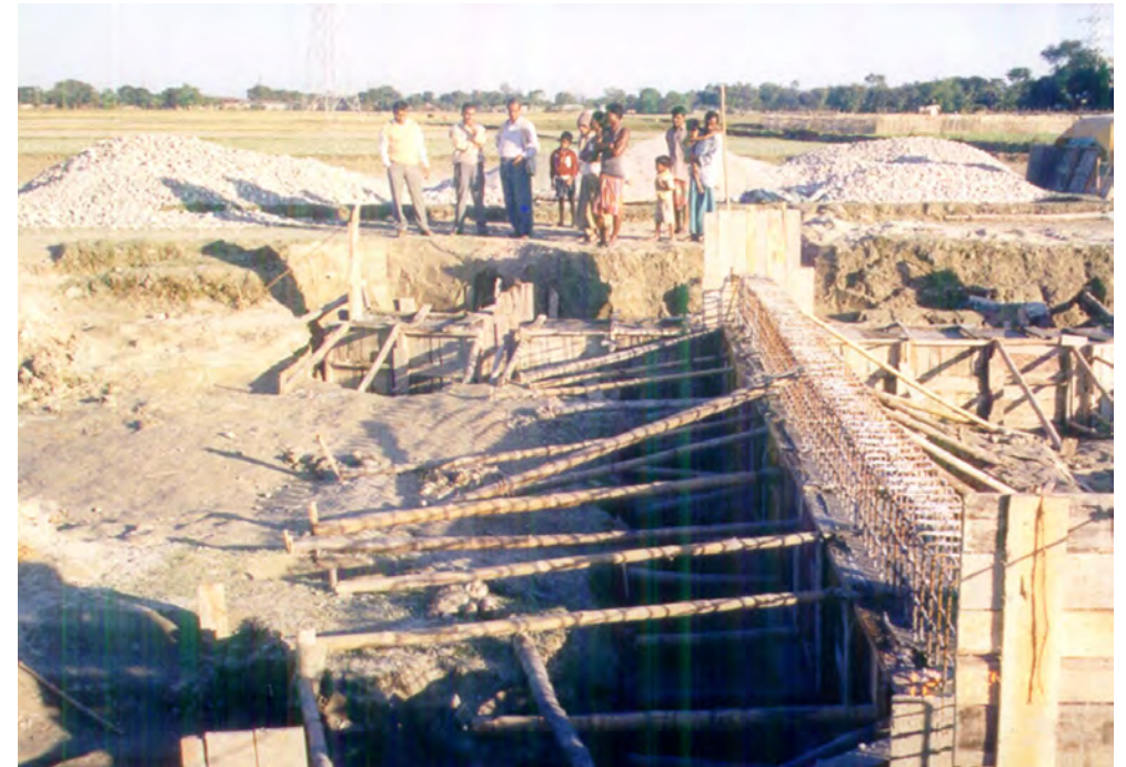
Figure 2 : Construction d'un bassin tampon dans une ravine pour assurer la retenue des eaux souterraines
