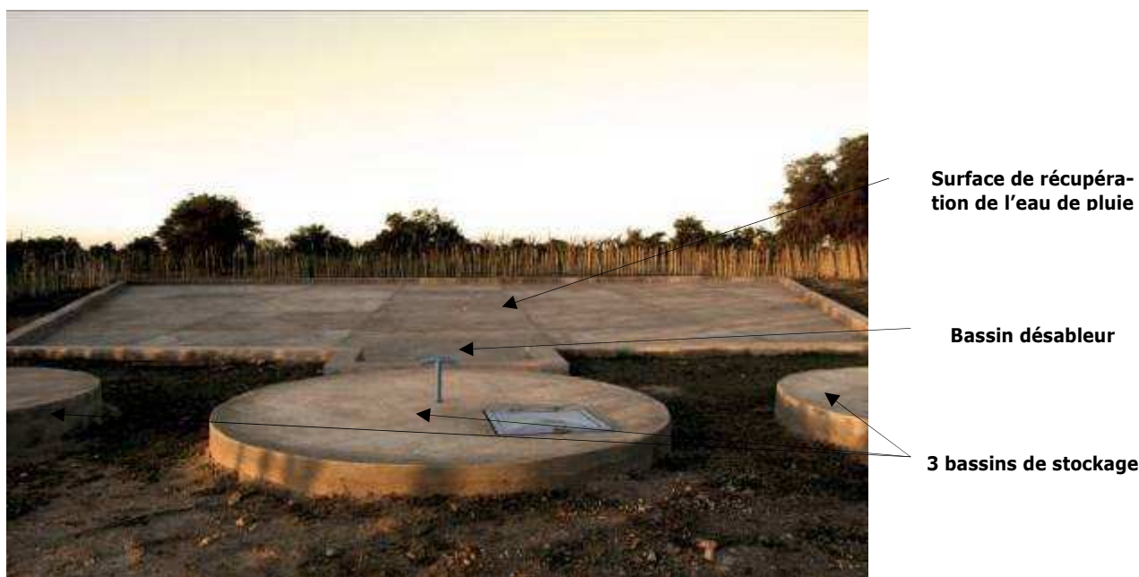
Impluvium construit par Objectif Sud à Ankiliabo (Source : M. Renault)
