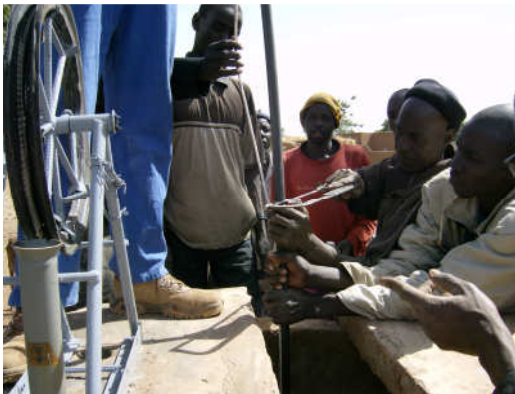
mise en place du bloc, tuyau et corde
