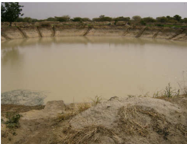
vue du réservoir avec les rampes d'accès
