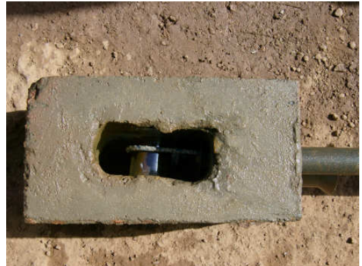
le bloc de prise d'eau
