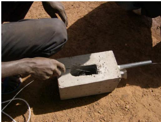
Technique pour mettre la corde dans le tuyau : le fil de fer
