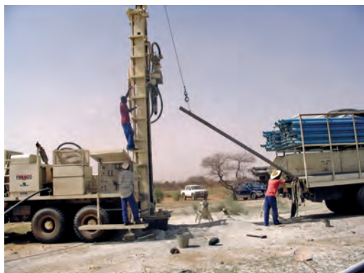
Manœuvre de tige en phase de foration
