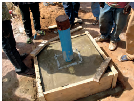
Réalisation d'une margelle
