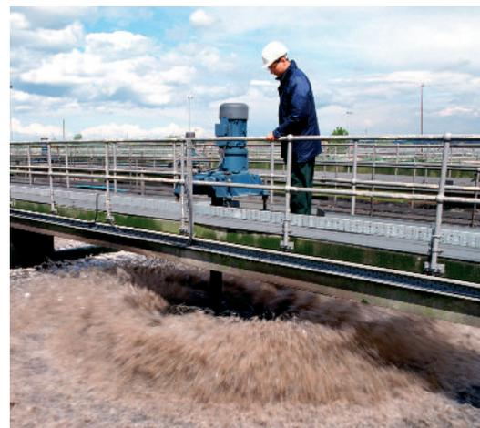
amenées jusqu'à des usines de traitement des eaux. Là, elles cheminent à travers des bassins de rétention, de clarification, et seront nettoyées biologiquement ou chimiquement au cours du processus. Après traitement, l'eau est renvoyée dans le circuit naturel.
