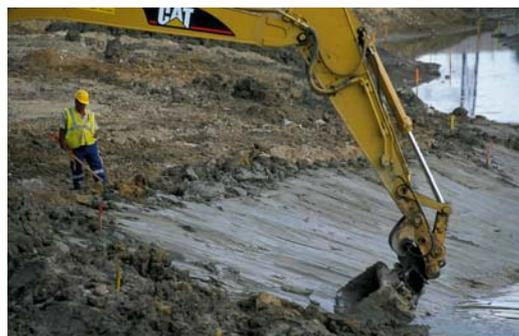
► Lissage d'argile pour l'étanchéité du contre-fossé (Parc du Chemin de l'Ile à Nanterre)
