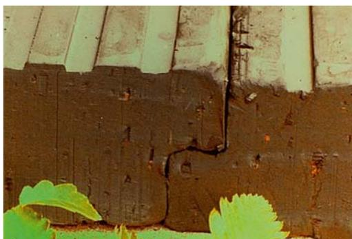
► Dalles de bentonite autobloquantes : mise en place et compactage à la dame vibrante
