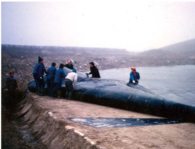
► Déroulement de la membrane et tranchée d'ancrage
