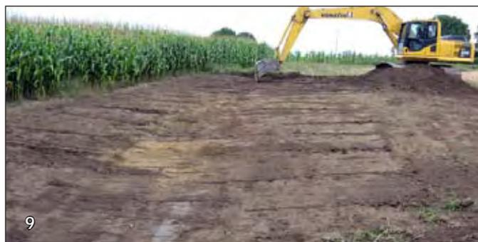
Photos 8 et 9 : Aménagement d'une rigole par creusage latéral
