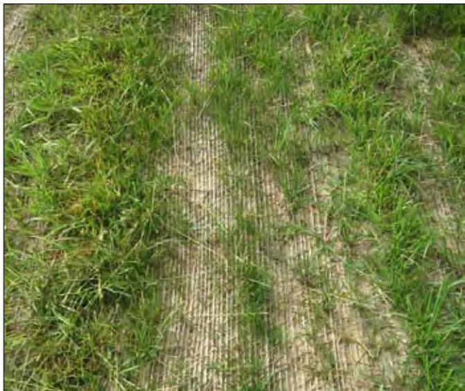
Photo 14 : Protection du sol d'une voie d'eau par une toile de jute
