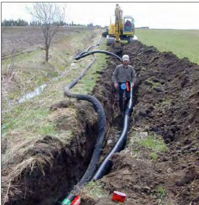
Photo 4 : Installation d'un drain enrobé de 100 mm pour le drainage et d'un drain non perforé de 150 mm pour l'avaloir dans une voie d'eau pentue
