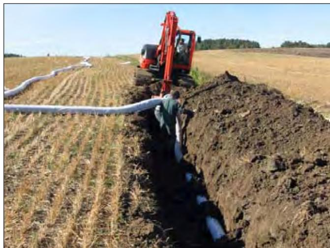
Photo 7 : Installation d'un drain enrobé avant la mise en forme d'une voie d'eau
