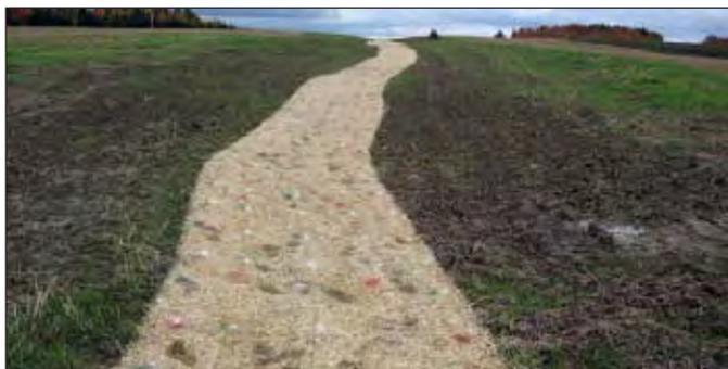
Photos 2 et 3 : Aménagement d'une voie d'eau dans une raie de curage érodée
