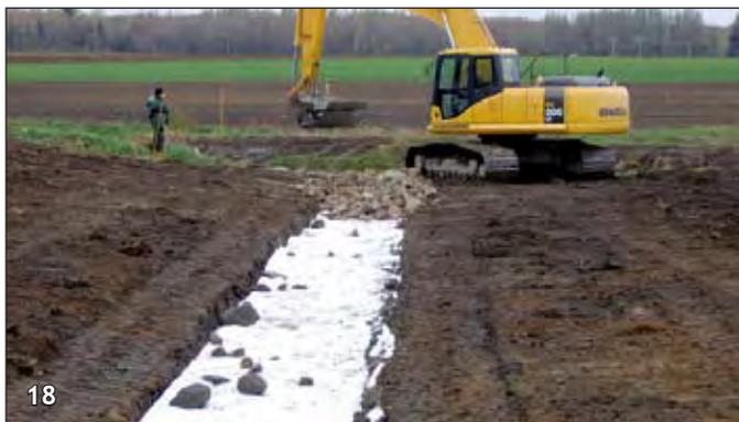
Photos 17, 18 et 19 : Fabrication d'une rigole enrochée sur toile géotextile
