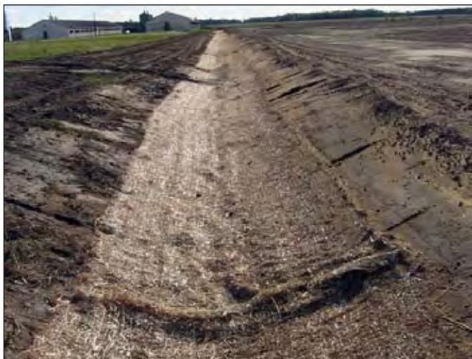
Photo 15 : Protection du sol d'une voie d'eau par un filet de paille
