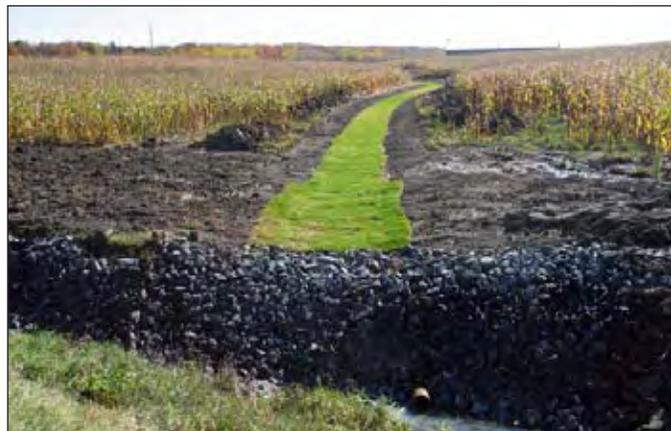
Photo 16 : Protection d'une voie d'eau par des plaques de gazon
