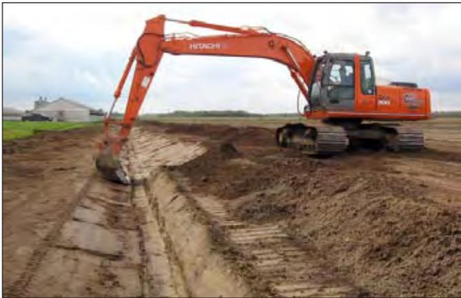
Photos 10 : Aménagement d'une voie d'eau par élargissement du canal en «V»
