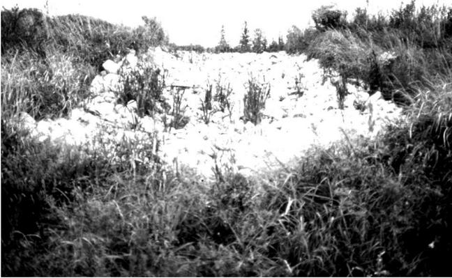
Figure 2. Être attentif à l'eau qui se creuse un chenal sous les descentes enrochées ou autour de celles-ci.
