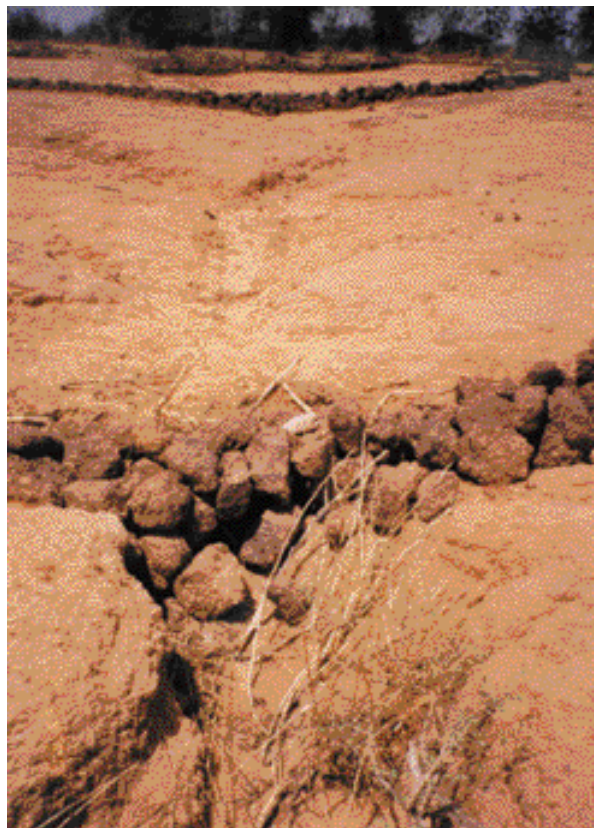
Fig. 3.2.(14) Exemple de travaux de réparation le long d'un ravin
