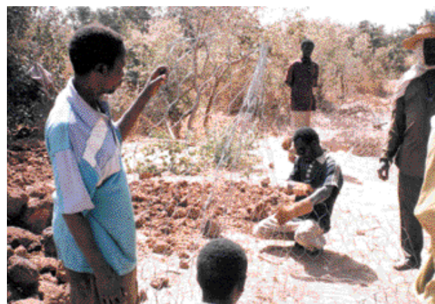
④ Assemblage du gabion
