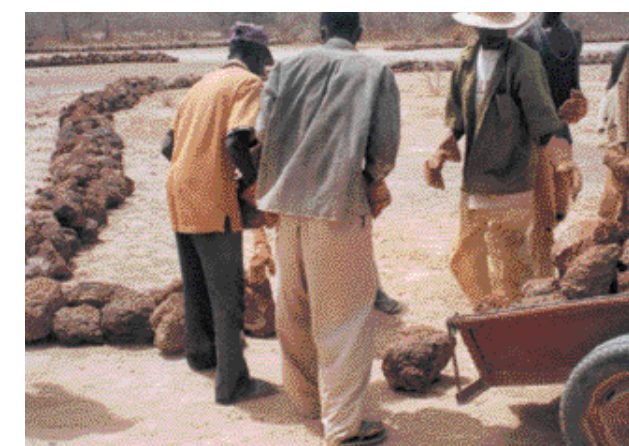
Travaux d'installation des diguettes en pierres
