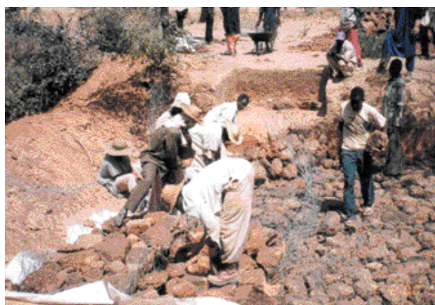
⑤ Travaux de dépôt des pierres
