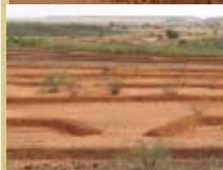
**Principe** on crée des très grandes demies lunes sur de larges surfaces dénudées, endurcies ou encroûtées. Il s'agit d'ouvrages présentant un bourrelet non franchissable, un gradin et un fossé. La banquette finie mesure 80 cm et 70 cm de profondeur. Les banquettes sont disposées en quinconce et l'interligne est de 30 m. Elles vont collecter les eaux qui ruissellent sur les espaces nus.
