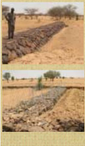
**Principe** C'est un ouvrage pierreux construit au travers d'une zone de ruissellement fort. Il doit être toujours être ancré dans le sol (fondation). D'une hauteur moyenne de 0.5 à 0.8m, la largeur de la digue dépend du débit maximal du ruissellement qui doit la traverser. Plus le courant est important, plus il faut prévoir d'enchaînement de digues.
