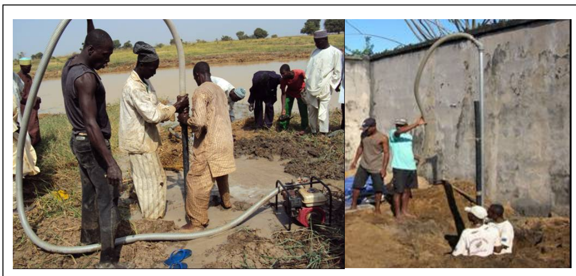
Figure 4. Forage au lançage à l'eau : le washbore
