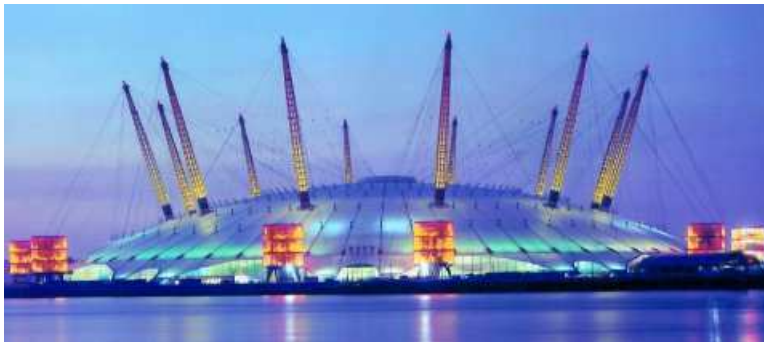
Londres, Salle de concert « Million Dome » (Recyclage des eaux de toitures)
