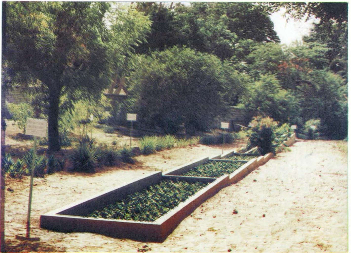
*Photo 2 : Vue d'ensemble du lagunage à macrophytes. Au 1<sup>er</sup> plan les 3 canaux en série de l'épuration secondaire. Au second plan les 3 canaux en parallèle pour l'étude de l'épuration tertiaire et notamment de l'abattement bactérien.*
