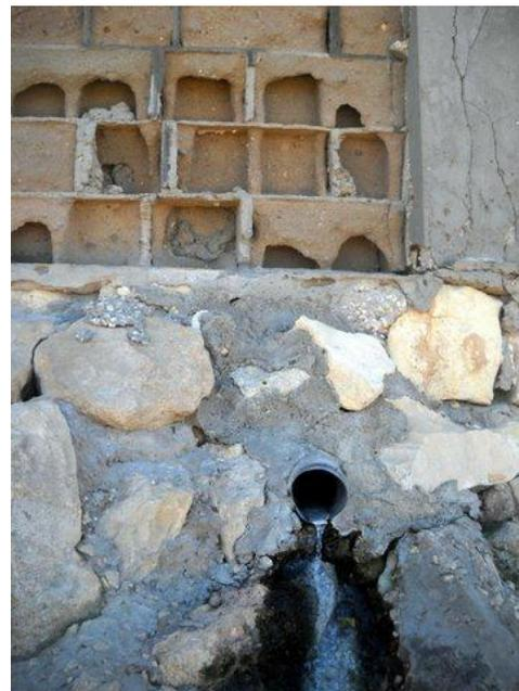
Figure 19 : Tuyau d'évacuation d'eau usée en mer de la Copefrito (RAJAONARIVELO, 2013)
