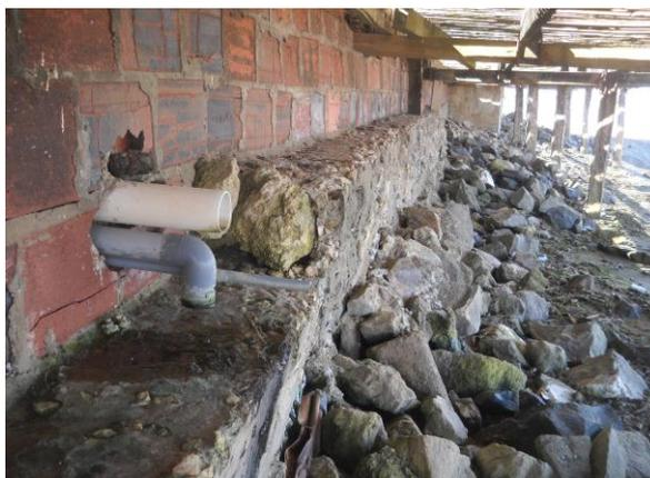
Figure 13 : Tuyaux d'évacuation d'eaux usées d'un hôtel au bord de la mer (RAJAONARIVELO, 2012)
