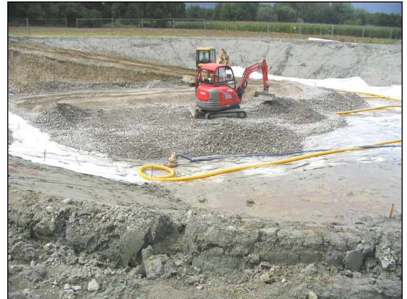
Mise en place de la couche drainante et des gravettes
