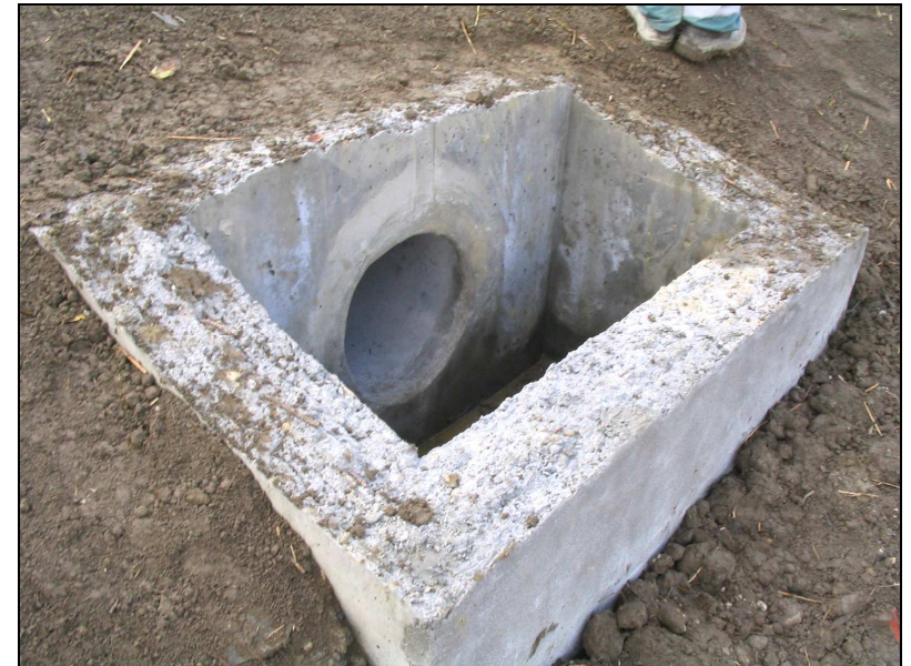
Ouvrage de surverse
