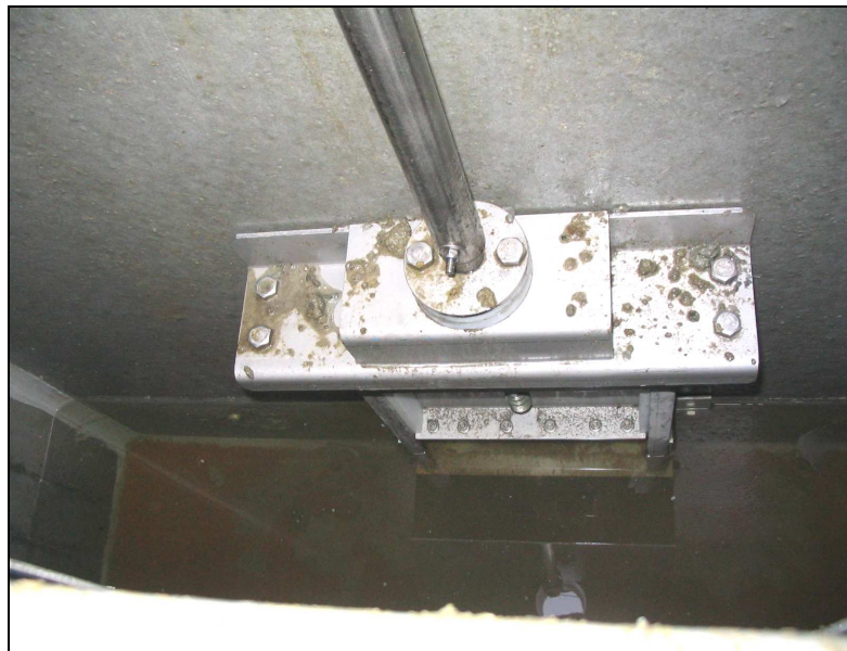
Regard de sortie : vanne de régulation du débit
