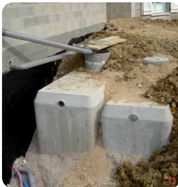
Installation d'une citerne de récupération de l'eau de pluie.
