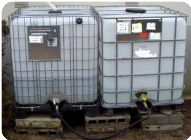
Installation de récupération uniquement apte à fournir de l'eau pour les usages extérieurs.
