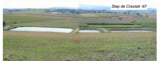
Il est préconisé de disposer de trois lagunes pour assurer un bon niveau de fiabilité du traitement. Si l'objectif de rejet comprend la désinfection, le nombre de lagunes peut être augmenté.
