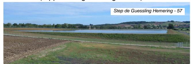
La forme des bassins doit être régulière. Les formes anguleuses sont le siège de dépôts importants et favorisent les zones mortes.
