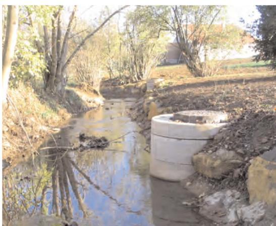
Regard implanté dans le lit mineur de la rivière ⇒ impact sur la berge, le lit, l'écoulement
