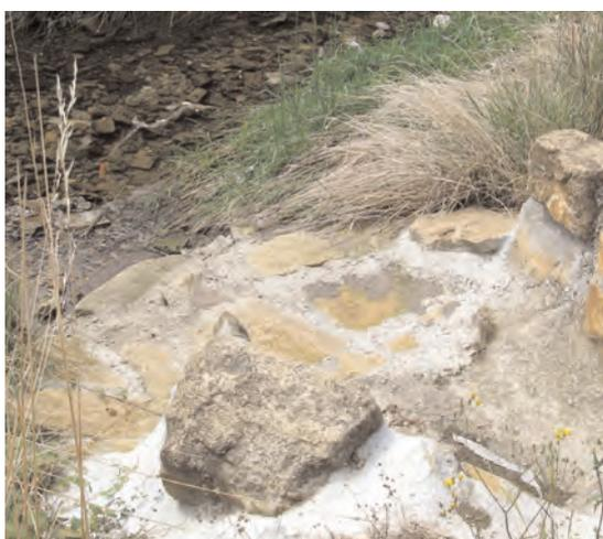
Délestage de réseau réalisé en enrochement et directement sur la berge du cours d'eau ⇒ impact sur la berge
