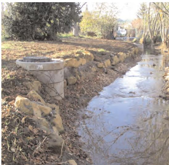
Après travaux, réfection des berges avec enrochement ⇒ impact sur la berge, le lit, l'écoulement
