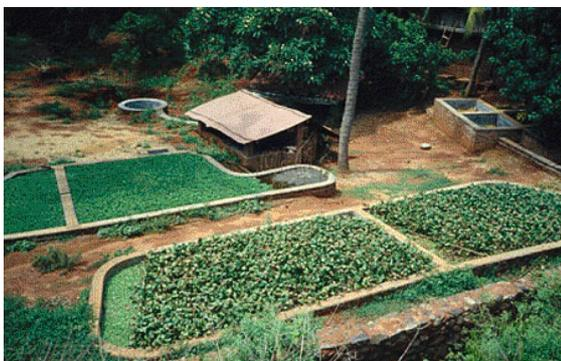
Figure 4: Système de traitement des eaux usées avec les jacinthes d'eau.
