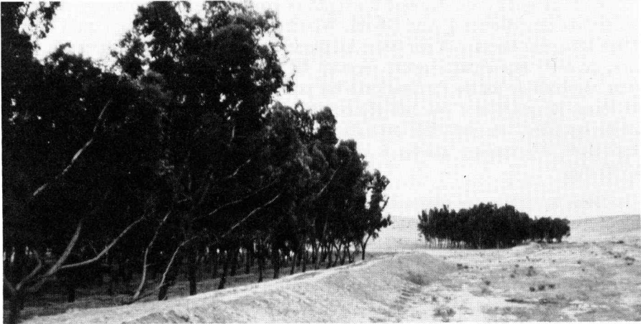
Au Néguev, au sud de Beersheba, en Israël, une digue judicieusement construite en bordure d'une plantation retient et entrepose de rares eaux de ruissellement.
