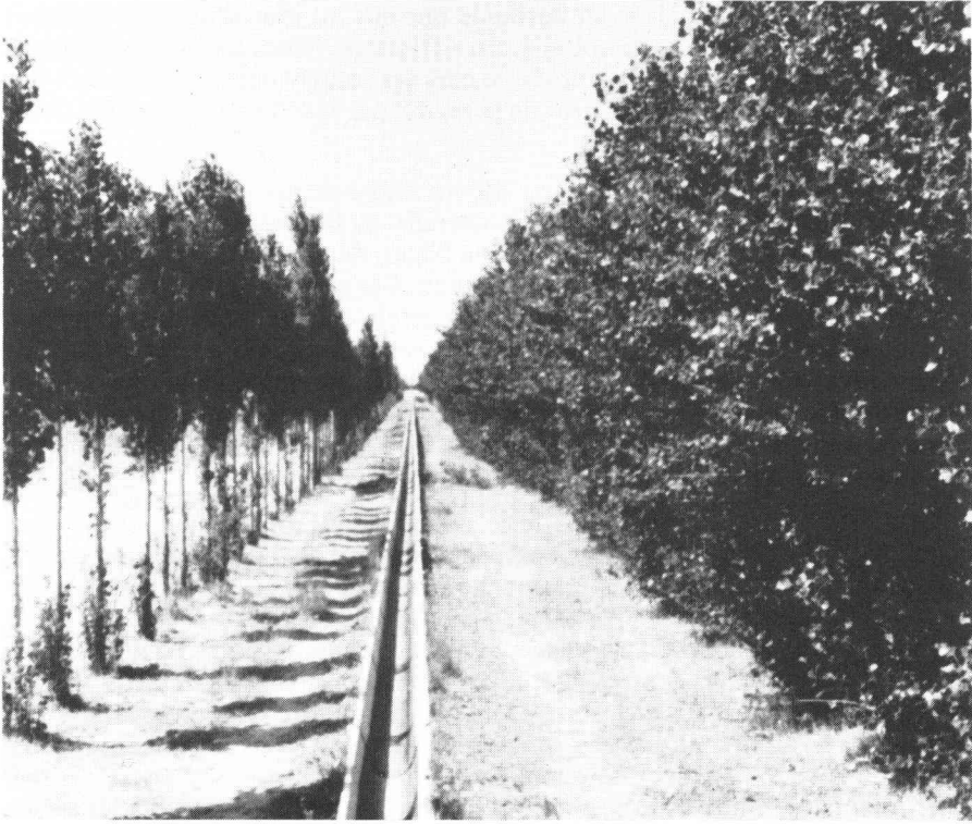
Une rigole en béton achemine, selon les besoins, de l'eau à des rigoles latérales sans revêtement, adjacentes à des rangées de peupliers (Tunisie).
