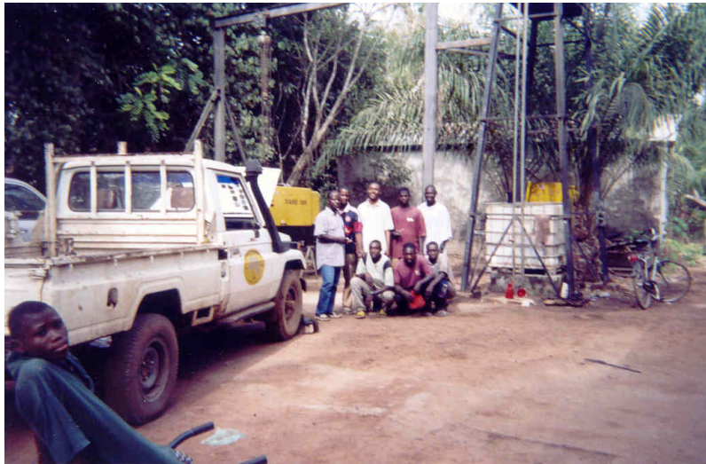
Forage de puits
