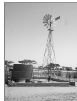
Station de pompage éolien (ALIZES)
