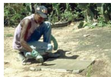
Fabrication des plaques de béton
