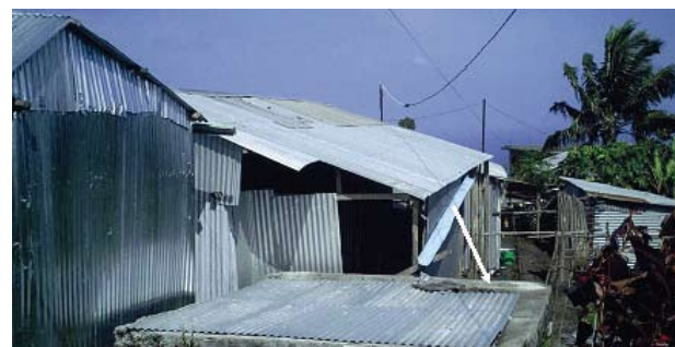
Citerne collective : 15 m de longueur et 4 m de hauteur
