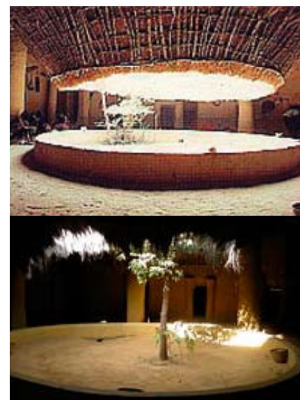
Cour centrale où l'eau de pluie est récupérée
