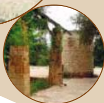
Cuve en pierre/maçonnerie
