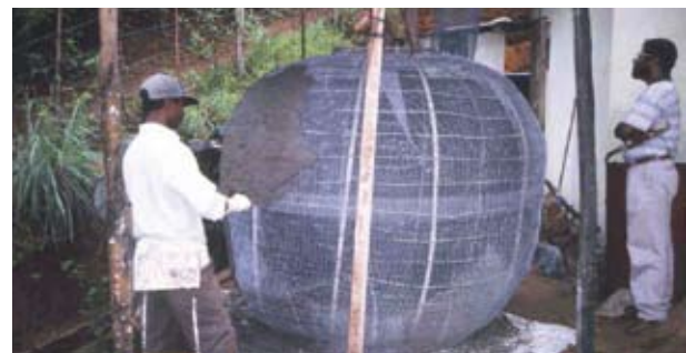
Jarre en cours de construction
