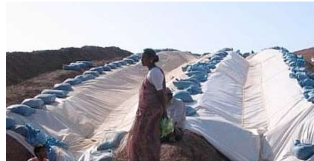
Vue de la première usine à rosée (1 000 m 2 dans une première phase) en construction dans l'état de Gujerat – Inde – 2006
