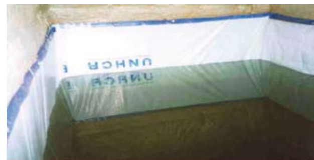
Intérieur du réservoir-bâche
