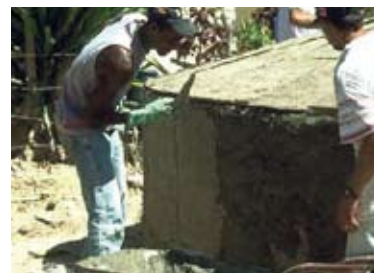
Application de l'enduit intérieur
