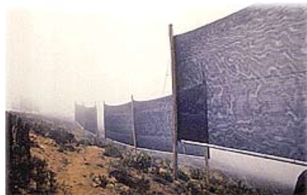
Collecteurs de brouillard sur la crête montagneuse d'El Tofo, au Chili.
