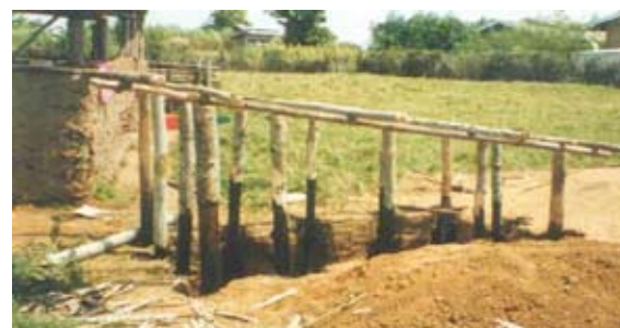
Construction de l'abri
