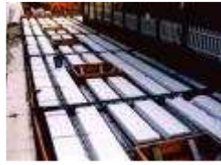
Fabrication des éléments à la chaîne dans des usines (photo indicative. Sur la photo, on voit, en fait, des pré-dalles en béton).
