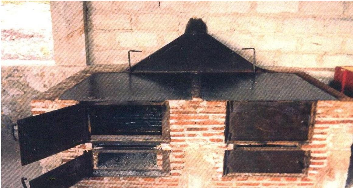
Ici on peut voir les détails de construction des plaques de cuisson ainsi que la cheminée, les deux clefs de réglage du tirage, les deux boîtes à feu avec leurs portes et leurs grilles en fonte ainsi que les deux cendriers. L'ardeur du feu peut être contrôlée par l'ouverture ou la fermeture des clefs de réglage et des portes.
