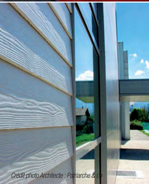
Crédit photo Architecte : J.P. Lafargue, C. Lapassade et J.M. Mogan
