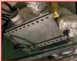
VMC double flux DOFEO installée dans les combes.
