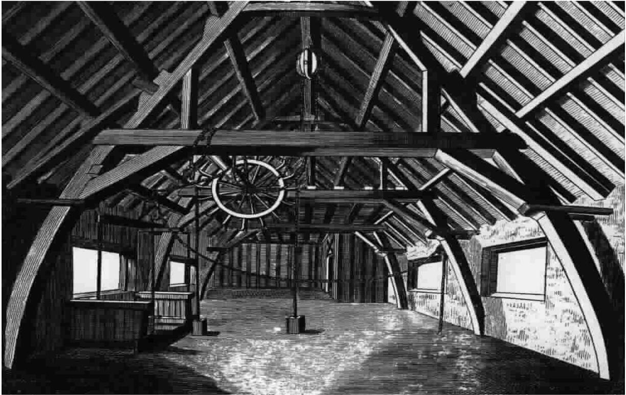
*La partie supérieure, le grenier où le grain passe par la trappe et la roue d'où l'on monte le grain à la touraille*
