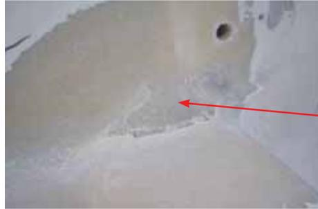
Avant de passer la meuleuse, tous les éléments qui contaminent la surface, comme l'huile et le silicone, doivent être lessivés et éliminés avec un solvant adapté. Pour le meulage, on choisira de préférence un papier abrasif de grain 40.
