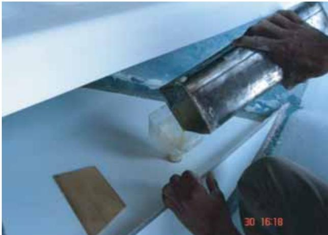
Ci-contre, le PU est versé dans l'espace de flottaison. Le volume de mousse exact nécessaire pour remplir l'espace doit être calculé avec soin. Les instructions du fabricant concernant la température, les proportions du mélange, et le taux d'expansion de la mousse doivent être comprises et suivies à la lettre.
