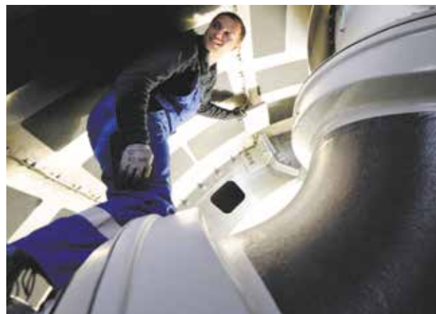
Une maintenance régulière doit être mise en œuvre pendant toute la durée de l'exploitation (estimée à 20 ans).
